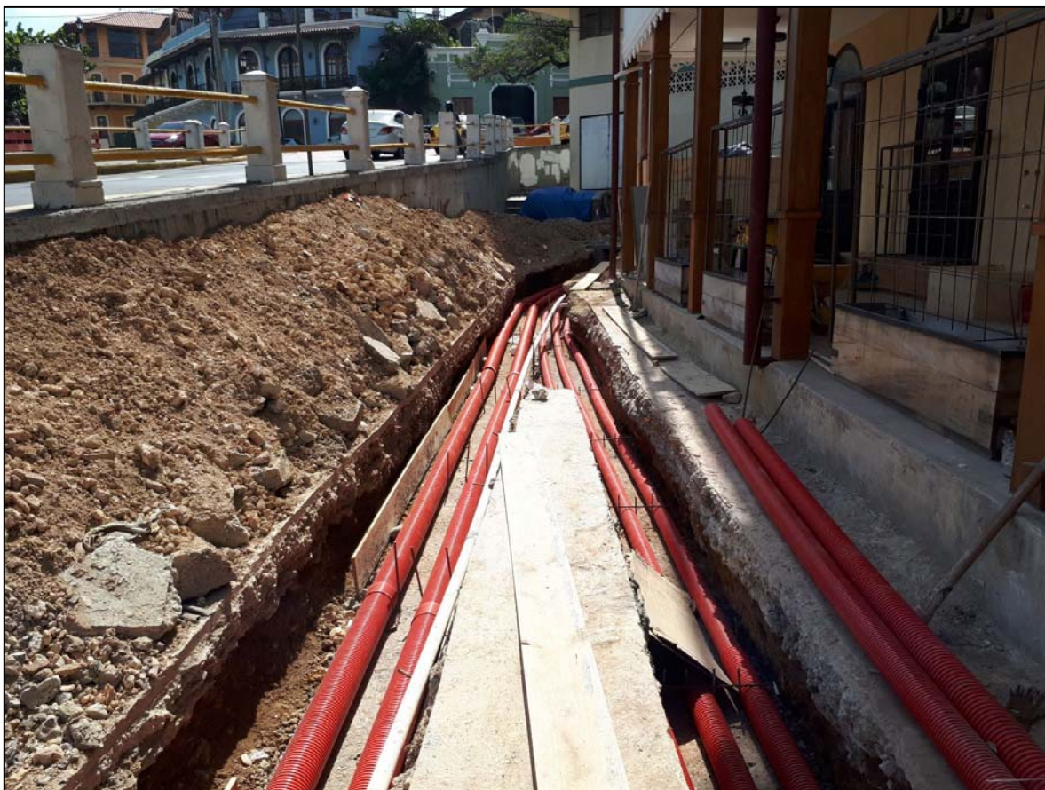
Foto No. 24: Colocación de Cables y tuberías y adecuación del área
