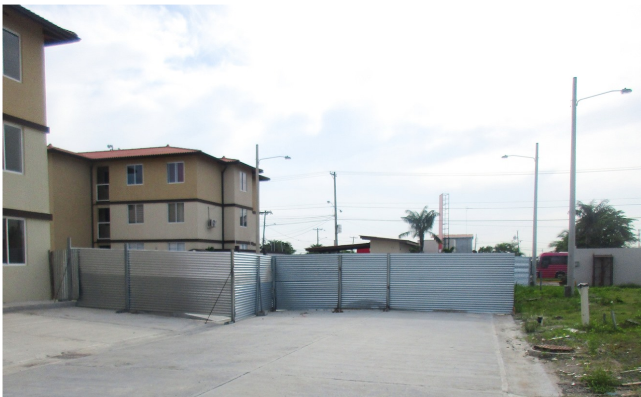
Fotografía 31 Áreas en construcción delimitadas por barreras físicas (hojas de Zinc)
