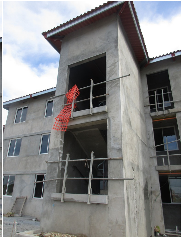
Fotografía 18 Barandales protegen de caídas accidentales a los trabajadores en los pisos superiores
