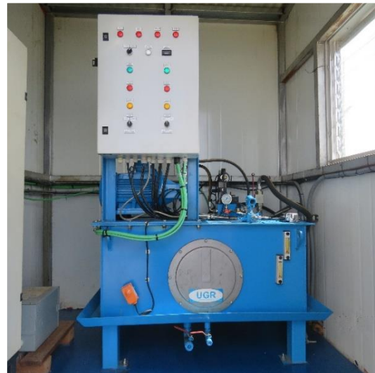
Foto 16 Bandeja de contención para evitar fugas de líquidos oleosos
