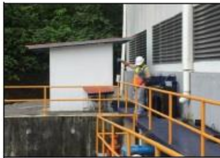
Canal de descarga
