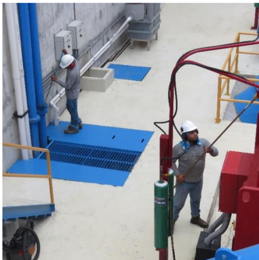
Foto 11 Uso adecuado de EPP
