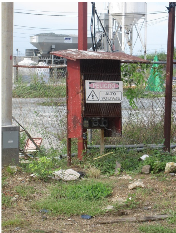
Fotografía 22 Otros temporales eléctricos, techados y con letreros de precaución
