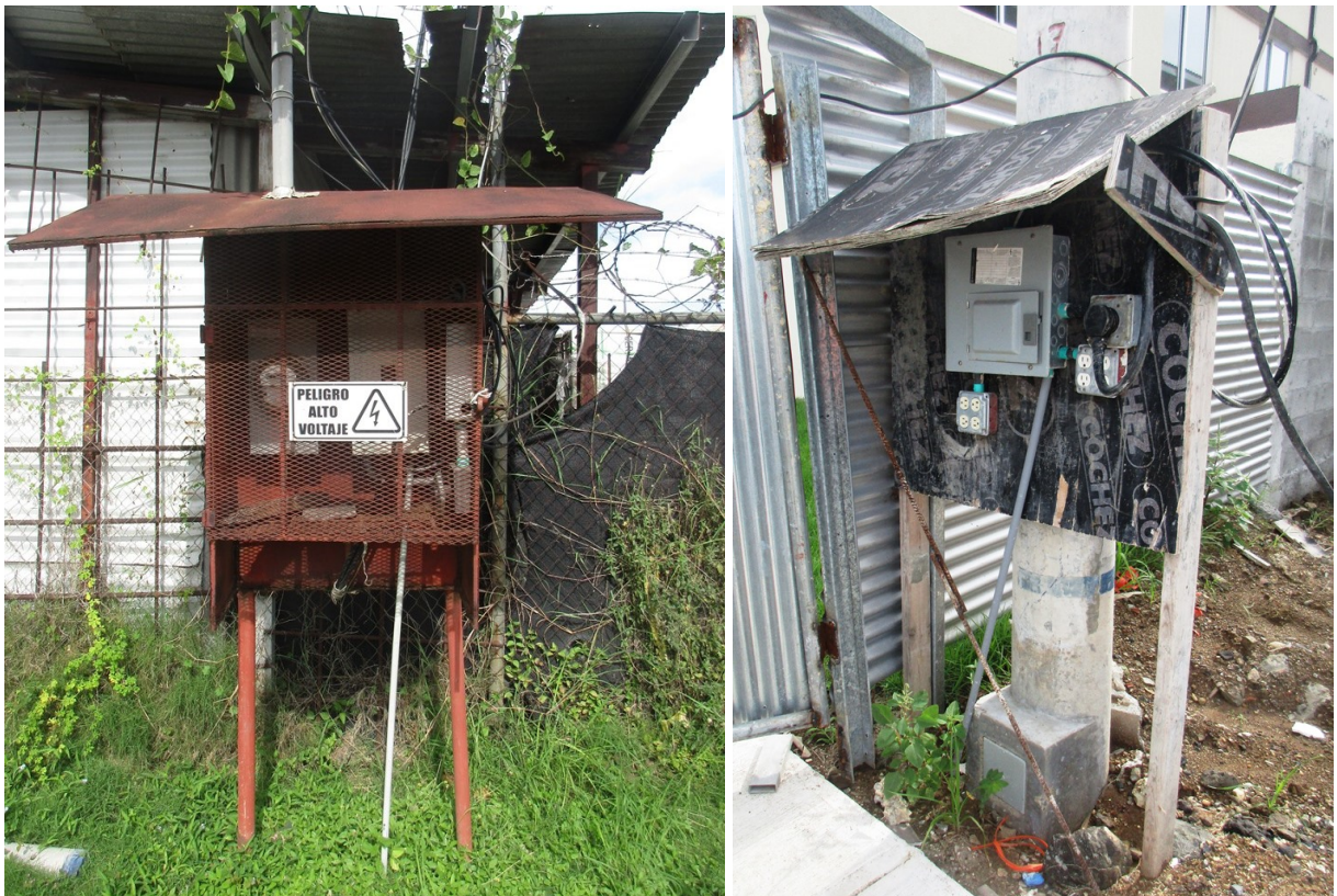
Fotografía 21 Temporales eléctricos sin cables pelados
