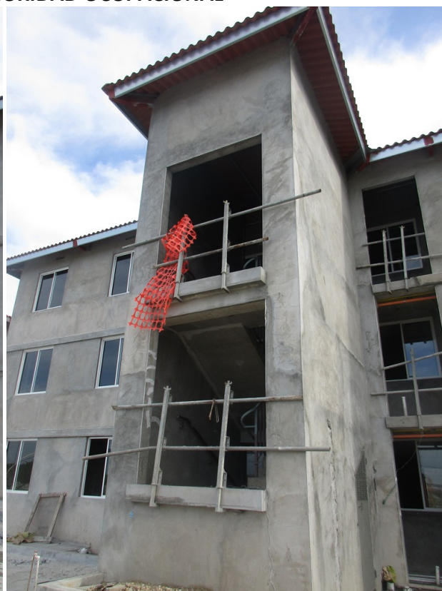
Fotografía 18 Barandales protegen de caídas accidentales a los trabajadores en los pisos superiores
