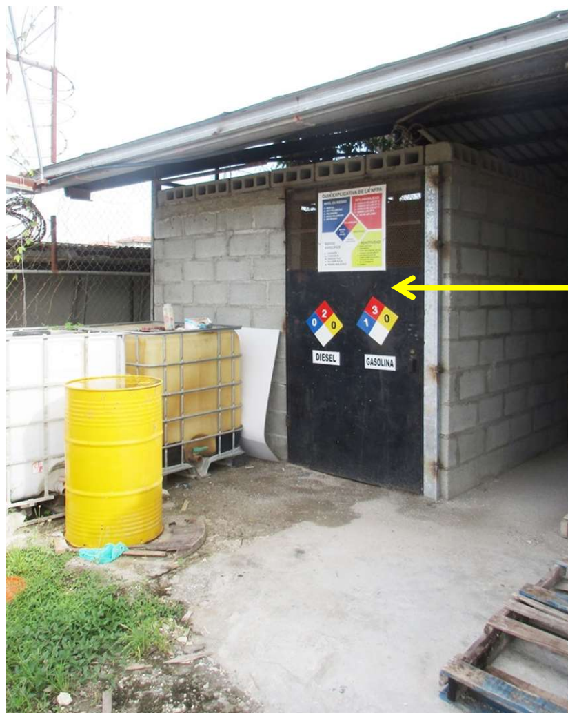
Fotografía 32 Caseta de Combustibles con su diamante NFPA para Diesel y Gasolina
