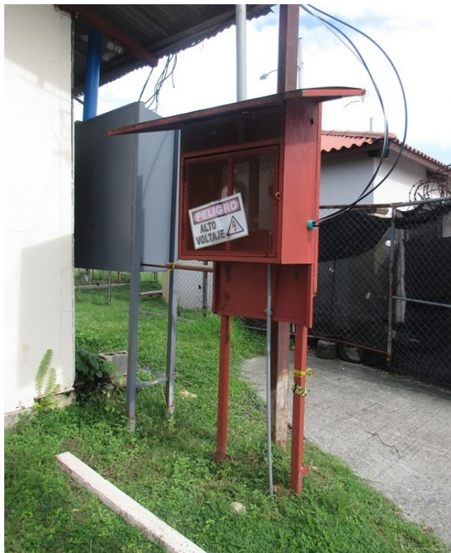
Fotografía 22 Otros temporales eléctricos, techados y con letreros de precaución
