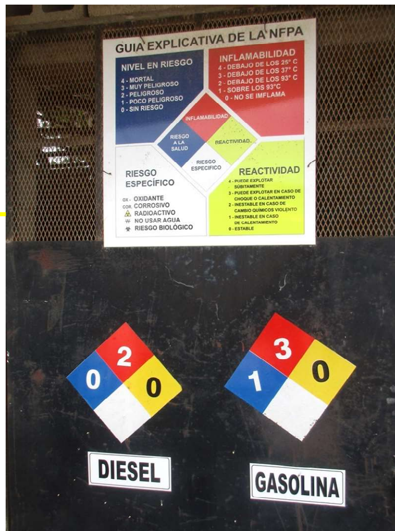
Fotografía 32 Caseta de Combustibles con su diamante NFPA para Diesel y Gasolina
