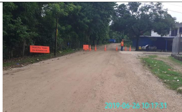
Fotografía No.62 Cierres parciales en la vía del proyecto. Sitio delimitado y señalizado y con personal para control de tráfico.
