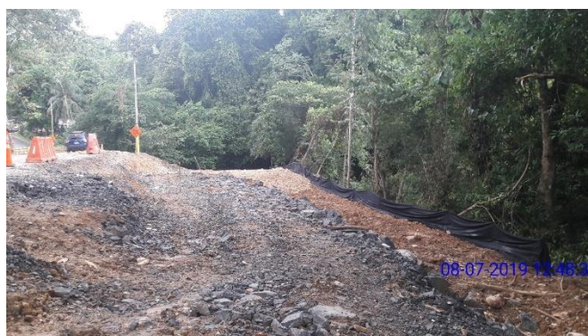
Fotografía No.30 Barrera de retención de sedimentos en el borde del cauce del río Nuevo Caimitillo (río La Puente).
