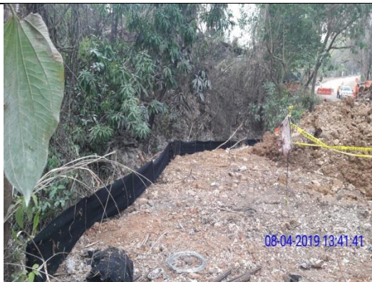
Fotografía No.25 Barrera de retención de sedimentos en el borde del cauce de la quebrada La Concepción.
