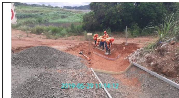
Fotografía No.37 Construcción de cuneta/zampeado para dar salida al flujo de agua.
