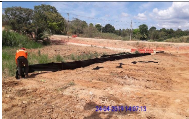
Fotografía No.26 Adecuación de barreras de retención de sedimentos en la estación 0K+870.
