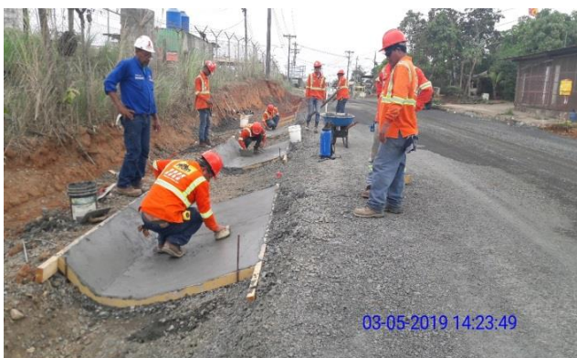
Fotografía No.35 Avance en la construcción de cunetas trapezoidales.
