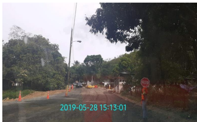
Fotografía No.49 Presencia de banderillero para el control de tráfico en la vía.
