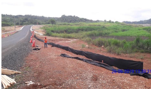
Fotografía No.27 Colocación de barrera de retención de sedimentos temporales en los bordes de talud.
