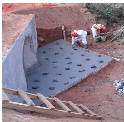
Fotografía No.36 Construcción de zampeados en las entrada/salida de cruces pluviales.
