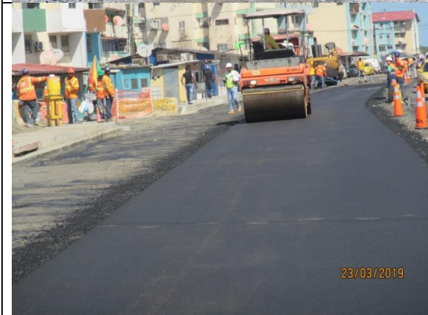
Verificación de la Instalación de calzada de asfalto en las vía principales de la feria.
