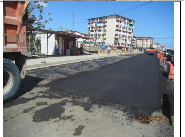
Verificación de la Instalación de calzada de asfalto en las vía principales de la feria.
