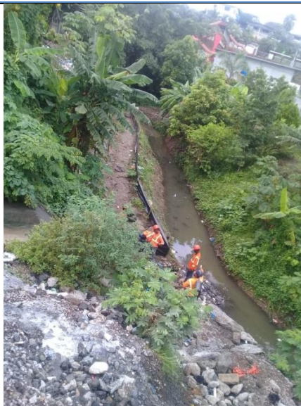
Control de erosión y sedimentación en las quebradas existente
