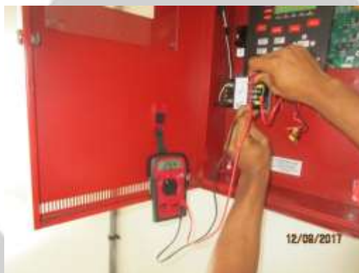
Fig. 4 y 5 – Voltaje de baterías. (13.65V/13.68V)
