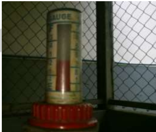
Fig. 3 - Nivel de Combustible 1/2 de tanque - Urge recargar el tanque se informó al personal de inmediato.
