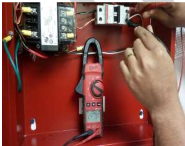
Fig. 4 – Verificación de voltajes AC del panel
