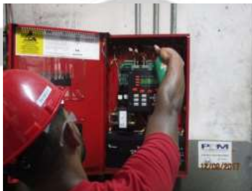
Fig. 2 y 3 – Voltaje de panel de refresco (117.9V/25.0V)
