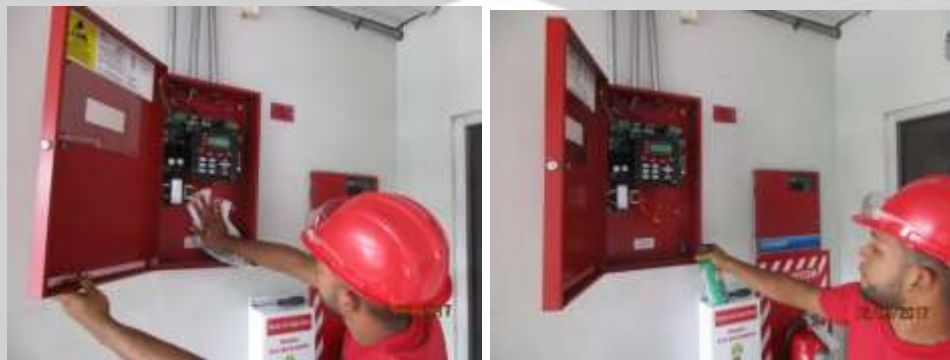
Fig. 3 – Voltaje de panel de calidad. (25.4V)
