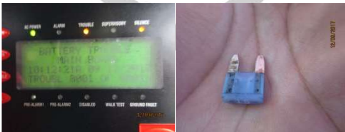
Fig. 8 y 9 – Remplazo de fusible de baterías ya que se encontraba quemado.
