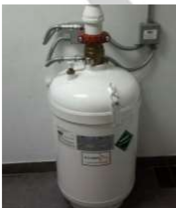
Fig. 2 – Tanque de agente se encuentra en buen estado presenta buena presión.
