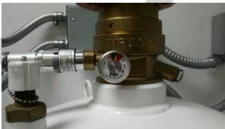
Fig. 2 – Tanque de agente se encuentra en buen estado presenta buena presión.
