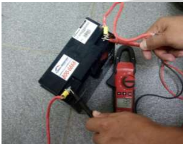
Fig. 5 – Verificación de voltajes de baterías del panel.
