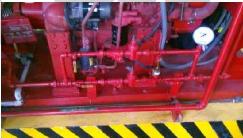
Fig. 2 – Válvulas de Sistema de Enfriamiento
