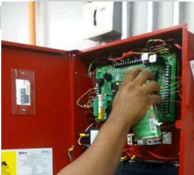
Fig. 4 – Verificación de voltajes AC del panel.
