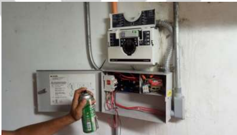
Fig. 6- Se realiza inspección y limpieza del Vesda.
