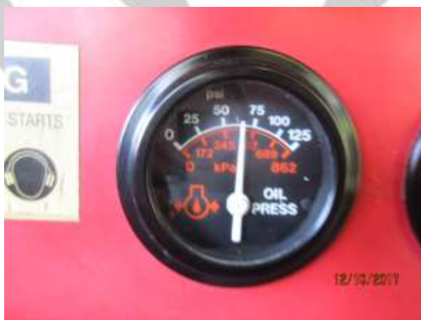
Fig. 3 – Presión de Aceite del Motor 65 PSI
