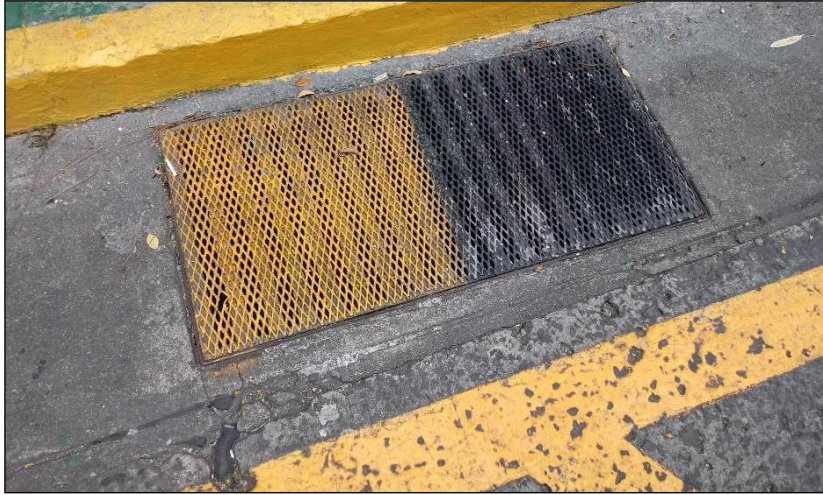
Fotografía No. 13: Instalación de mallas para evitar la entrada de sólidos en el sistema de evacuación de aguas residuales.
