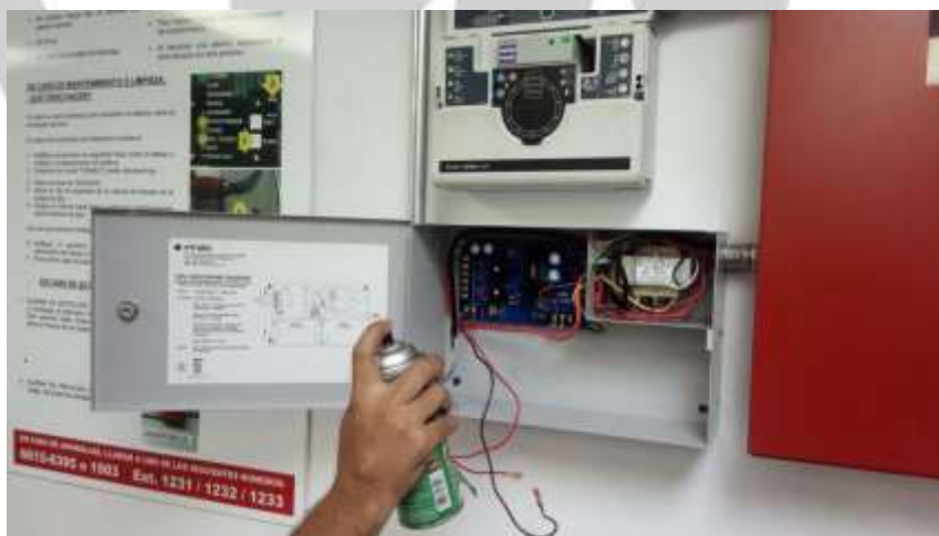
Fig. 6- Se realiza inspección y limpieza del Vesda.
