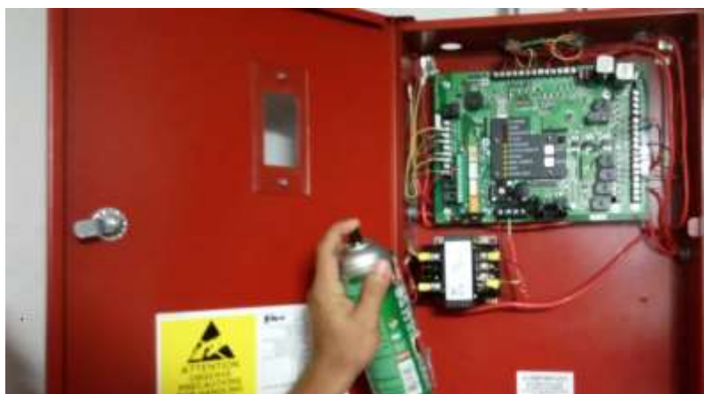
Fig. 3 – Verificación y limpieza de contactos electrónicos del panel.
