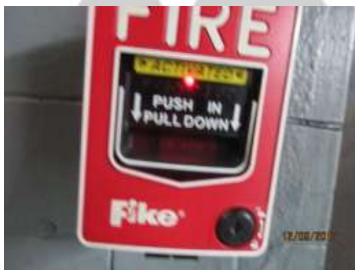
Fig. 7 – Se realizaron activaciones de sirenas mediante estaciones manuales
