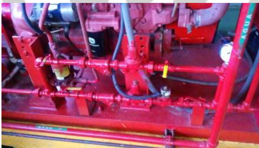
Fig. 2 – Válvulas de Sistema de Enfriamiento
