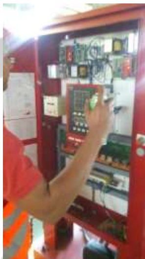
Fig. 1 – Limpieza de Controlador de Bomba
