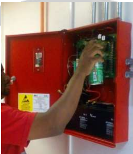
Fig. 4 – Verificación de voltajes AC del panel.
