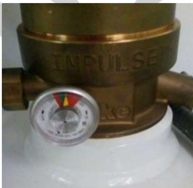
Fig. 2 – Tanque de agente se encuentra en buen estado presenta buena presión.
