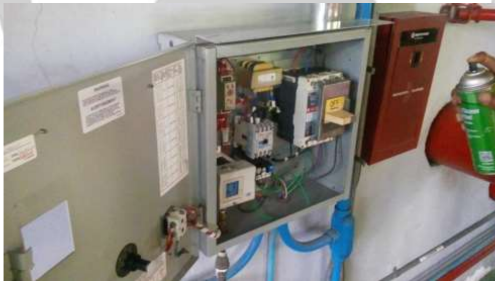
Fig. 1- Limpieza e Inspección de controlador de bomba jockey
