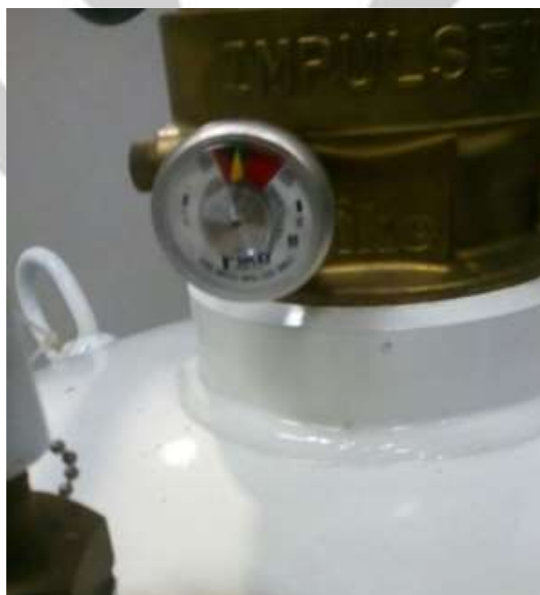
Fig. 2 – Tanque de agente se encuentra en buen estado presenta buena presión.
