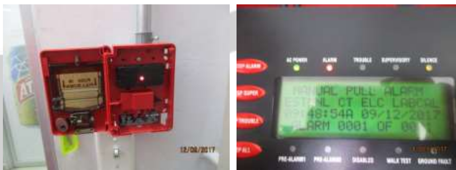
Fig. 6 y 7 – Pruebas realizadas en estaciones manuales.
