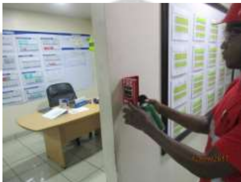
Fig. 6 – Limpieza e inspección de estación manuales.
