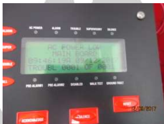
Fig. 8 – Prueba de fallo de corriente en el panel.
