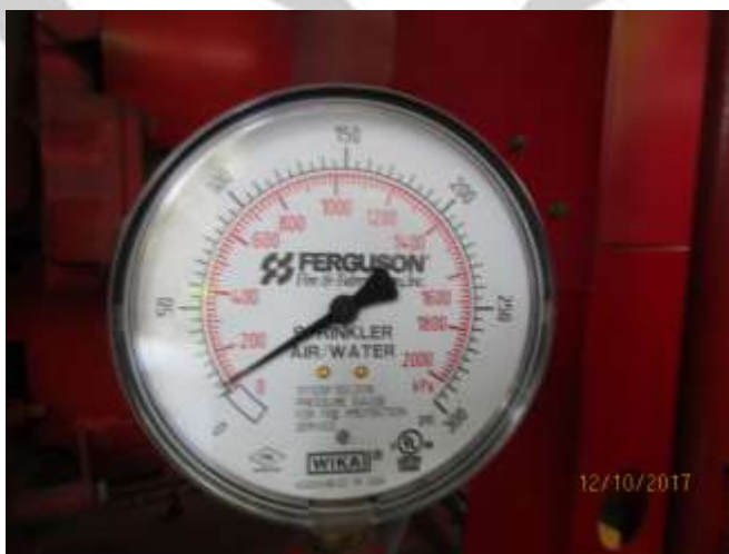
Fig. 3 – Manómetro de banco de enfriamiento debe ser remplazado. (Se recomienda el remplazo de manómetro del banco, ya que no es el tipo adecuado)
