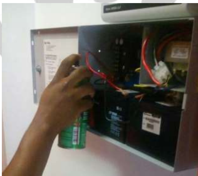
Fig. 6- Se realiza inspección y limpieza del Vesda.
