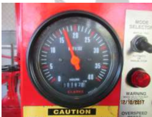
Fig. 3 – Manómetro de banco de enfriamiento debe ser remplazado. (Se recomienda el remplazo de manómetro del banco, ya que no es el tipo adecuado)
