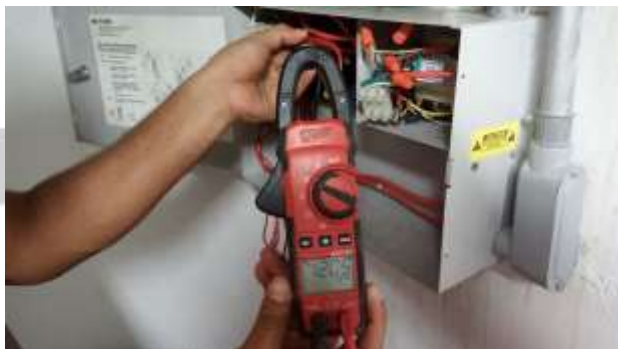
Fig. 7- Se verifica voltaje AC del panel vesda.
