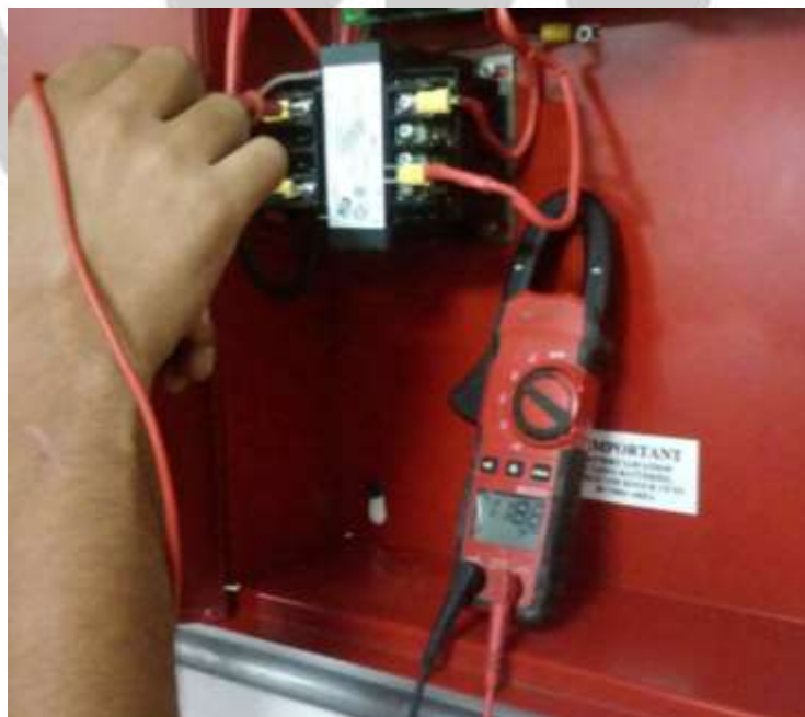
Fig. 4 – Verificación de voltajes AC del panel.
