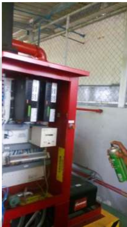
Fig. 1 – Limpieza de Controlador de Bomba
