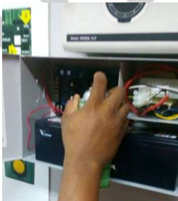
Fig. 6- Se realiza inspección y limpieza del Vesda.
