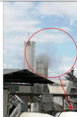
Foto 2: planta de concreto PremeXpress adyacente a la planta, durante la limpieza de sus filtros, generan gran cantidad de partículas que afectan y contaminan el patio de Concretetex PTY.
