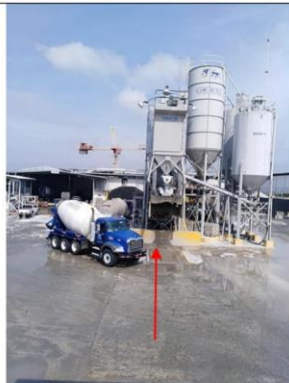
Foto 1: vista de los silos de despacho de materiales para el concreto. La misma en la parte posterior del edificio administrativo.
