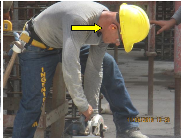
Imágenes 2.4.7 y 2.4.8. Vista del trabajador José Coronado utilizando una sierra circular para cortar laminas de madera y uso tapones auditivos.
