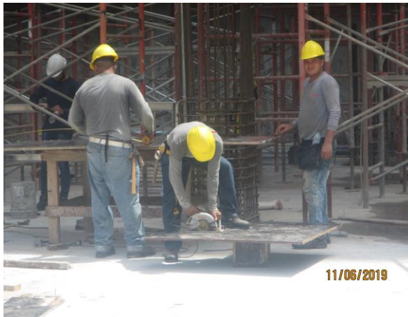
Imágenes 2.4.7 y 2.4.8. Vista del trabajador José Coronado utilizando una sierra circular para cortar laminas de madera y uso tapones auditivos.
