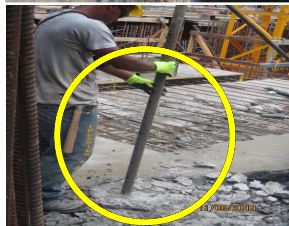
Imágenes 2.1.1.3 y 2.1.1.6. Fuentes generadoras de partículas en el Punto 1: (Nivel – 300) “Hospital Punta Pacífica Costa del Este”, (trabajos con el martillo picador y con el esmeril, fragmentación de concreto adherido a la superficie mediante un tubo de metal por un corto lapso)
