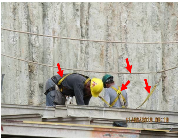
Imágenes 50 a 53. Vista de los distintos equipos de protección personal (cascos, mascarillas, arnés, línea de vida y tapones auditivos de espuma), utilizados por los colaboradores
