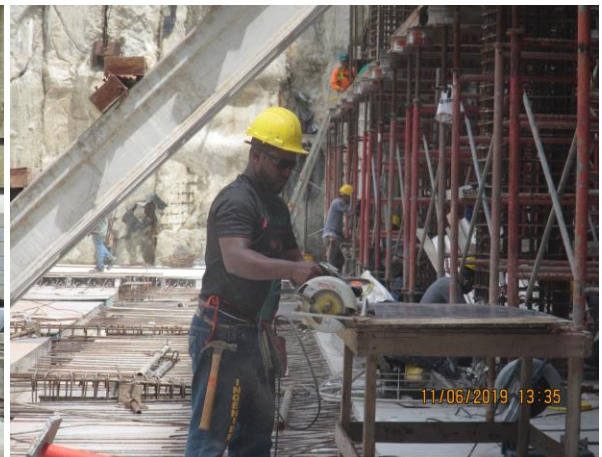
Imágenes 2.4.7 y 2.4.8. Vista del trabajador José Coronado utilizando una sierra circular para cortar laminas de madera y uso tapones auditivos.
