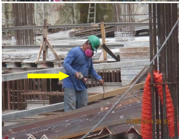
Imágenes 2.1.1.3 y 2.1.1.6. Fuentes generadoras de partículas en el Punto 1: (Nivel – 300) “Hospital Punta Pacífica Costa del Este”, (trabajos con el martillo picador y con el esmeril, fragmentación de concreto adherido a la superficie mediante un tubo de metal por un corto lapso)
