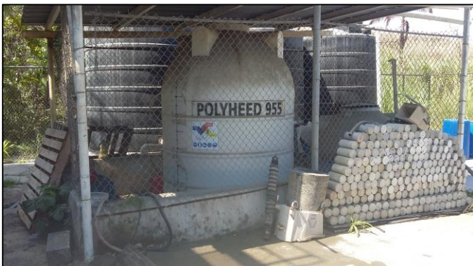
Imagen No.1. Se observó la tina para contención y almacenamiento de aditivos techada y cerrada con alambre ciclón.
