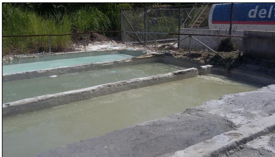
Imagen No.5. Se observación de las tinas de contención de sedimentos, en estado operativo.
