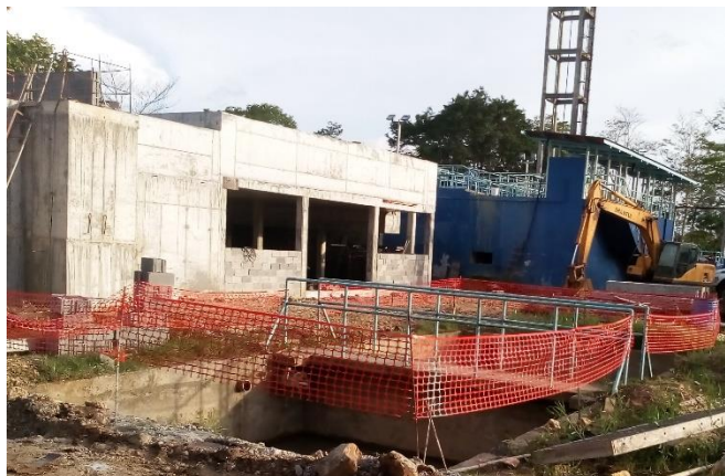
Fotografía # 1.28: Colocación de malla de seguridad, 12 de junio 2019.
