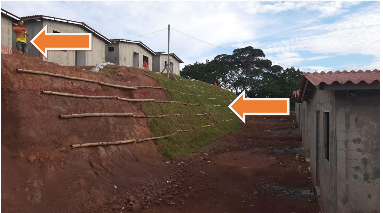
GRAMA INSTALADA EN TALUDE PERSONAL CON EQUIPO DE SEGURIDAD Y MALLA DE PROTECCION.
