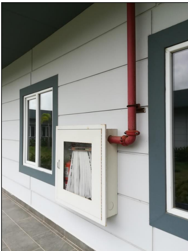
Foto #23. Se observa la manguera para utilizar en caso de incendios junto con un extintor.
