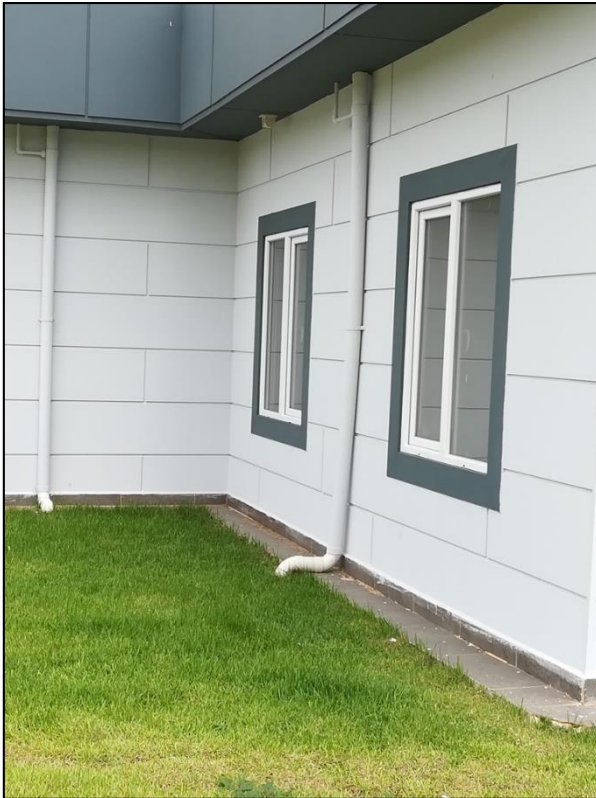
Foto #14. Bajantes para el agua pluvial localizados en varios sitios del techo del proyecto.
