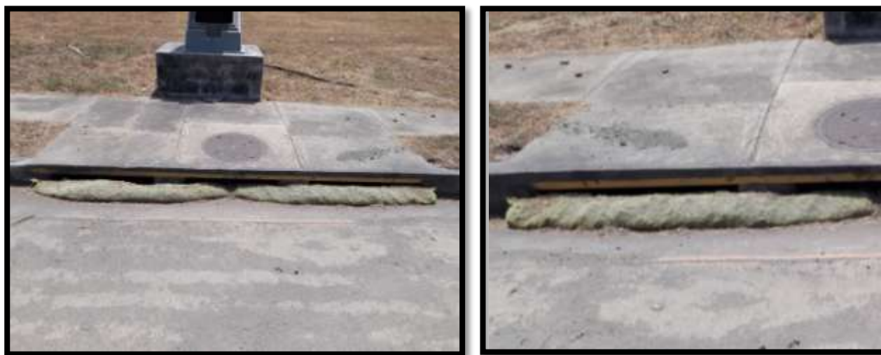
Foto 7-8: Rollos para retención de sedimentos en los tragantes pluviales a lo interno del proyecto.
