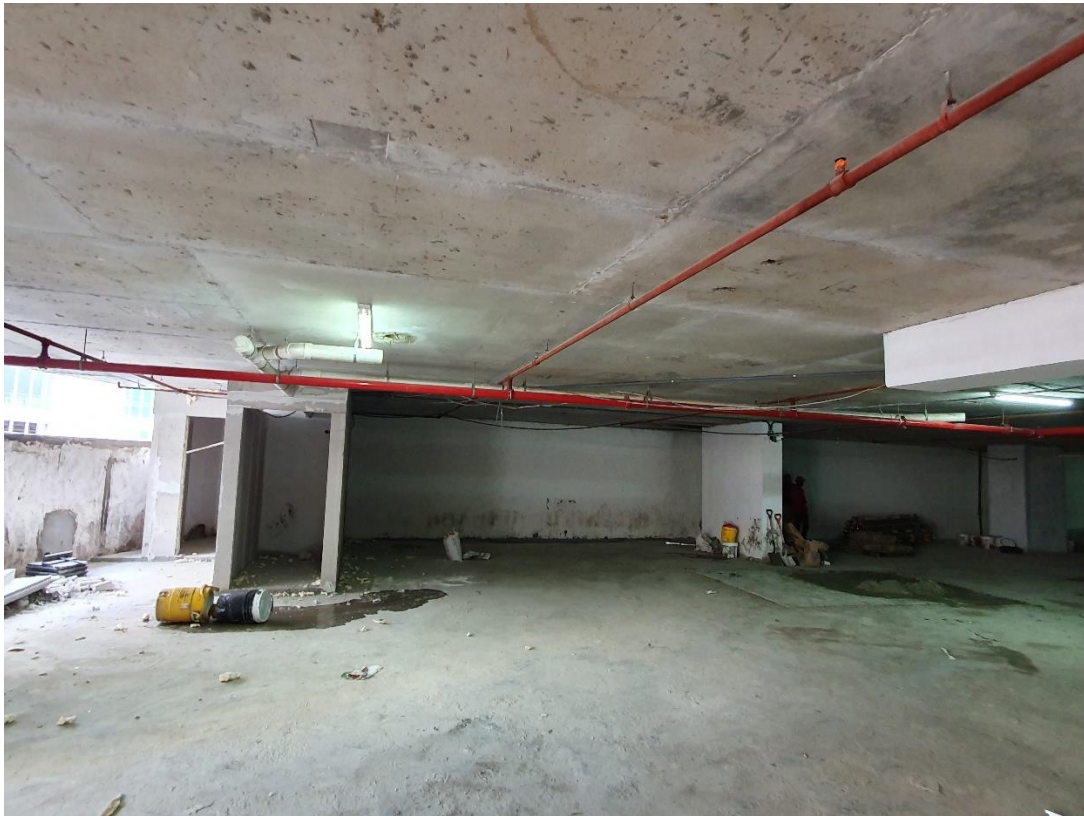
Foto No. A1-18. Tubería de agua para rociadores en torre 3.
