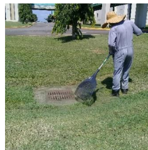
Limpieza de parrillas colectoras
