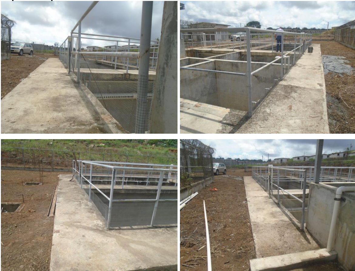
Colocación de la malla de metal en el perímetro de la estructura de la Planta, la cual impedirá el paso de la fauna.
