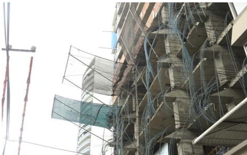
Medidas de seguridad para prevención de caída de objetos a transeúntes y colaboradores
