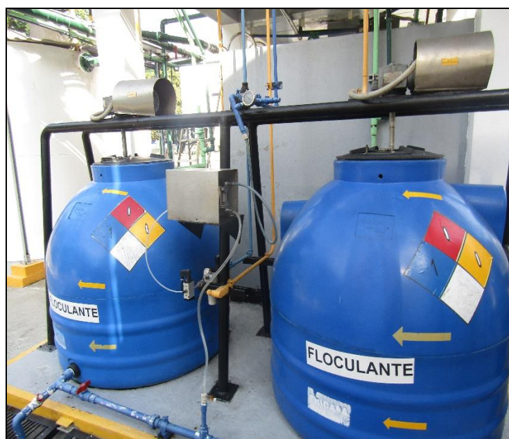
Fotografía N° 2. Tanques floculantes
