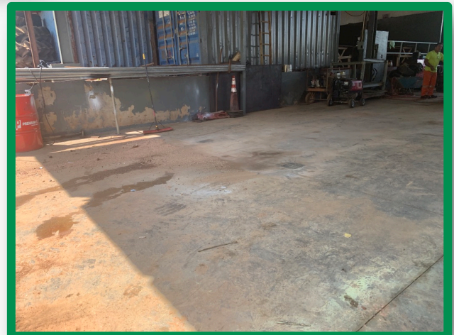
Piso en buenas condiciones, sin rastros de hidrocarburos
