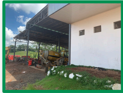
Vista lateral de galera, talud cubierto de vegetación para evitar el arrastre de sedimentos
