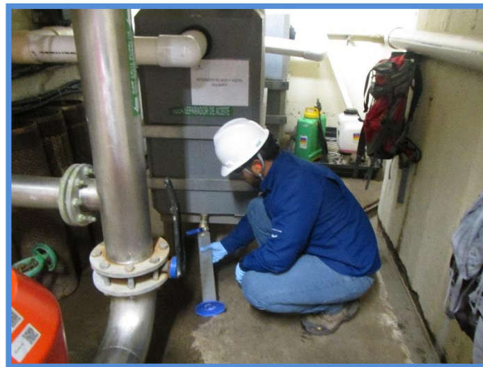
Fig.8. Recolecta de muestra en el sitio identificado como separador de agua y aceite izquierdo
