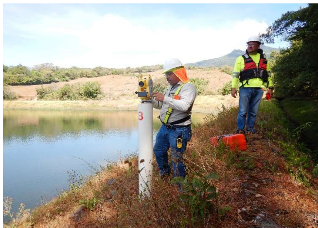
Fig. 5 Base de punto de control GPS denominado: R3.
