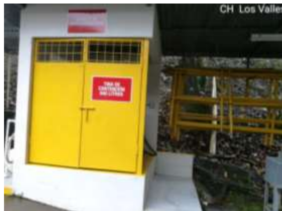
Fotografía No. 2: Almacenaje de hidrocarburos (combustible y aceites) con sus respectivas tinas de contención en CH Los Valles.
