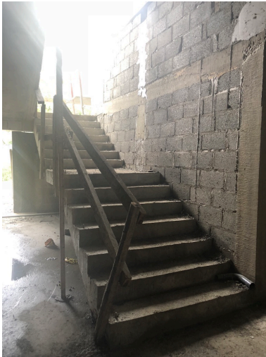
Varandales temporales de madera para las escaleras internas
