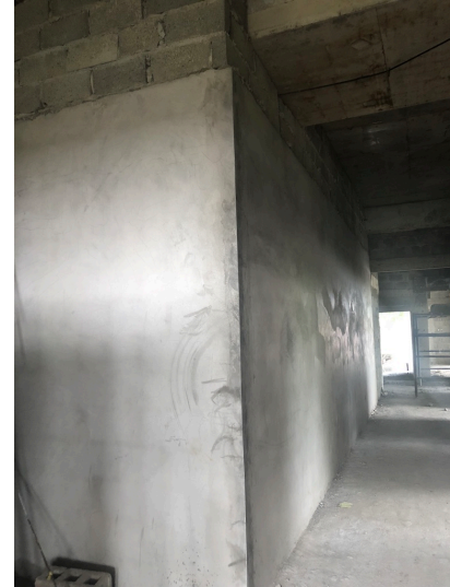
Avances cosntructivos, repello de paredes
