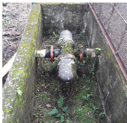
Imagen 2. Regulador de presión de Agua que abastece el sector
