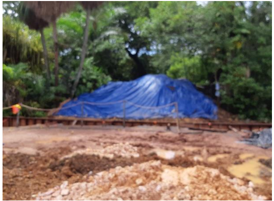
Material cubierto para evitar contaminación aérea
