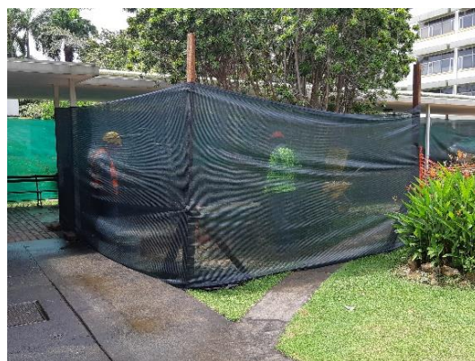
Maya perimetral para evitar accidente y contaminación de partículas
