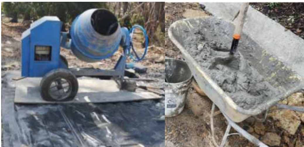
Foto 36 y 37. Mezcla de cemento, área cubierta con lona
