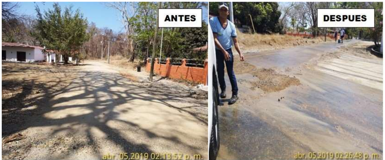
Foto #4 #5 y #6 Las vías son rociadas y/o limpiadas de escombros y lodos para minimizar el levantamiento de polvo.
