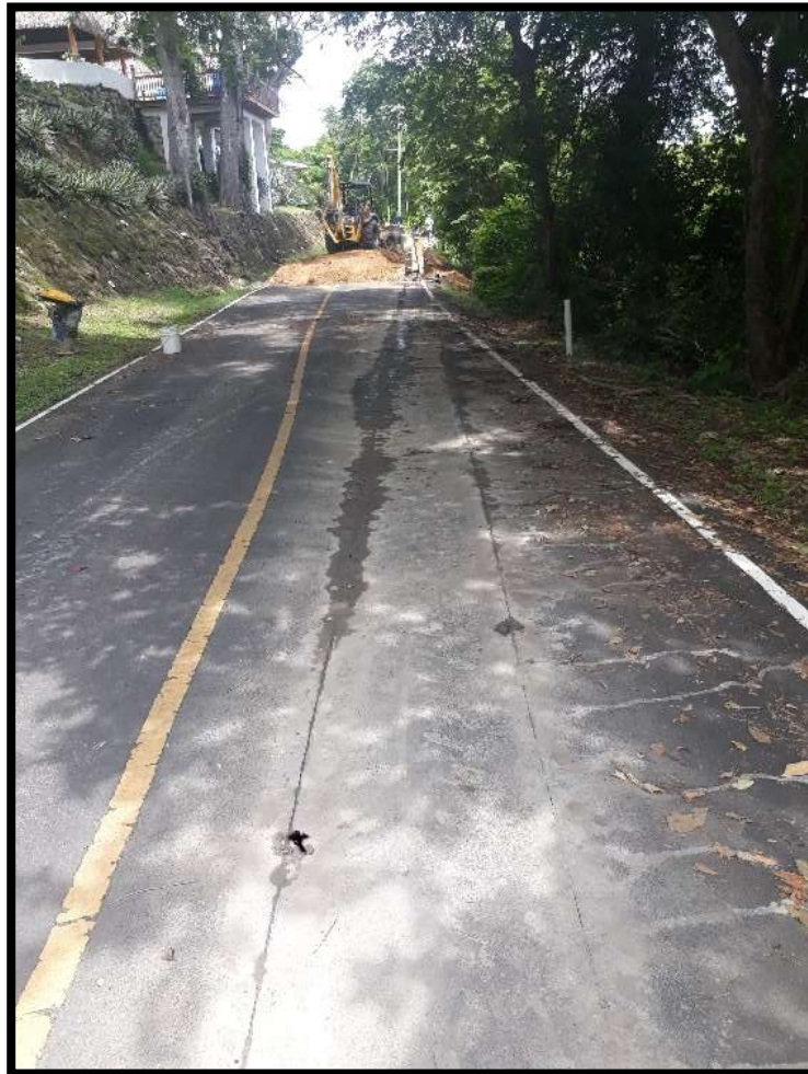
Foto #20. Corte del Pavimento.
