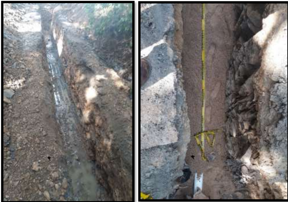
Foto #8. Excavación para Instalación de tubería de 6" colectora en el ramal 4 A Paseo Anayansi
