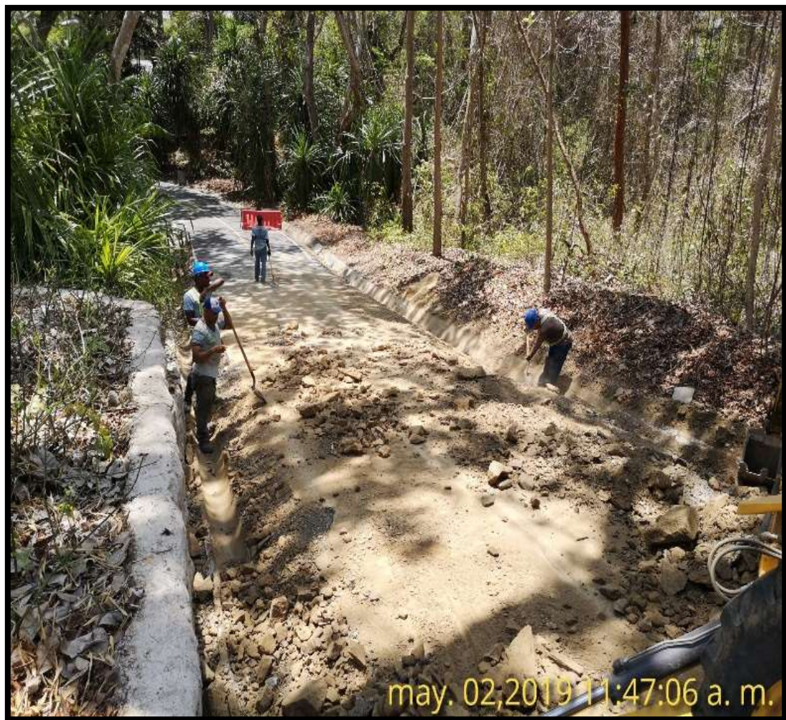
Foto #9. Controlar el escurrimiento y descargas de sólidos y de residuos al drenaje pluvial. Limpieza de cunetas
