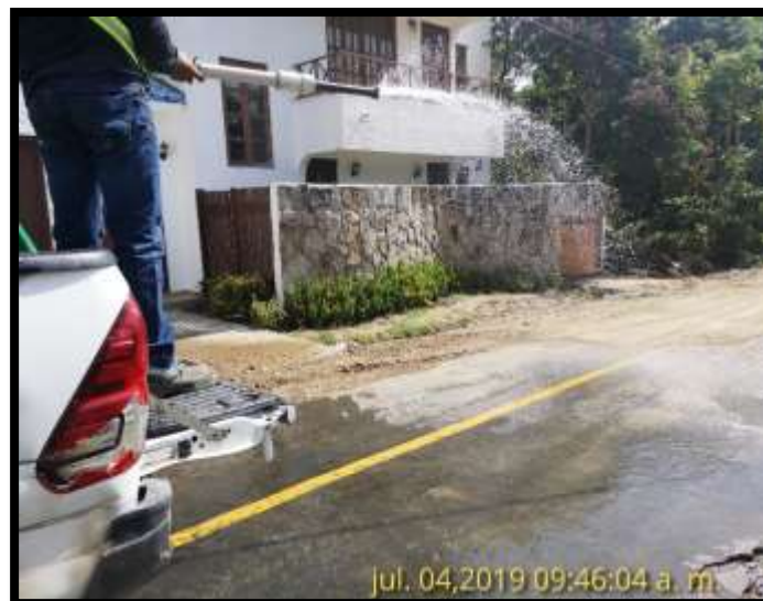
carro rociando agua en suelo, para evita expansión de partículas de polvo
