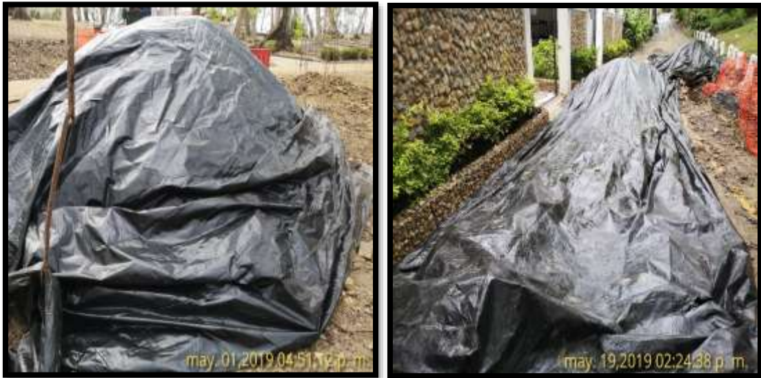
Foto #7. Materiales compilados dentro del área de trabajo cubiertos con una lona, para evitar su dispersión por el viento.
