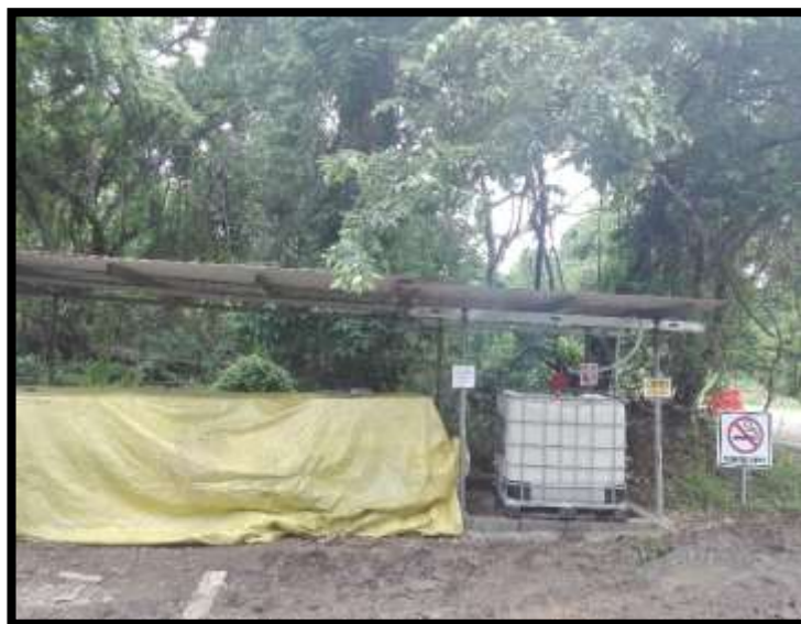
Foto #12. lugares de recepción y contención de residuos señalizados y aislados de otros almacenamientos (almacenamiento de aceites).
