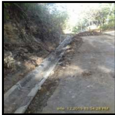
Foto # 27 #28. Reposición de cunetas
