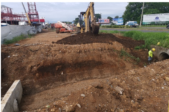
Foto 1) Trabajos realizados por el MOP de limpieza de tuberías en la servidumbre del proyecto
