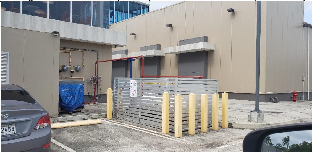
Fotografía 8. Tanque de gas de empresa Riba Smith con protección y letrero de advertencia
