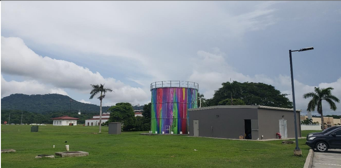
Fotografía 9. Tanque de almacenamiento de agua del sistema contra incendios
