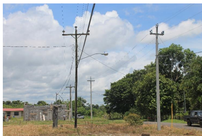
Figura 7. Acceso al proyecto desde la interamericana y los servicios básicos de la zona donde se habilitará el proyecto. Fuente: C, Gonzalez, 2019
