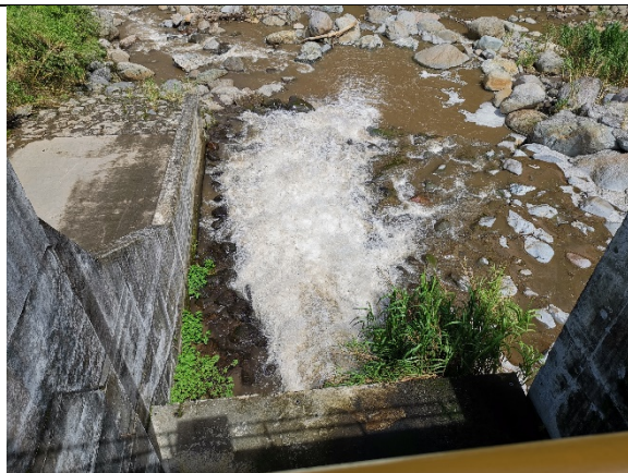
Foto 7) Descarga del caudal ecológico
