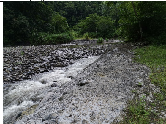
Foto 4) Se mantiene en buen estado el zampeado de protección del talud
