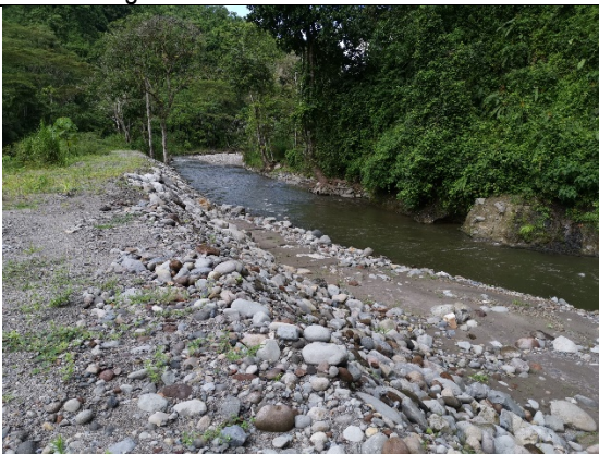
Foto 3) Estado de la ataguía de protección de la descarga en sitio de máquina
