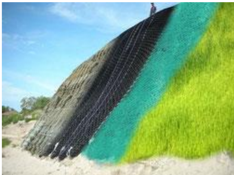
Vista de técnicas de control de erosión con geomantas
