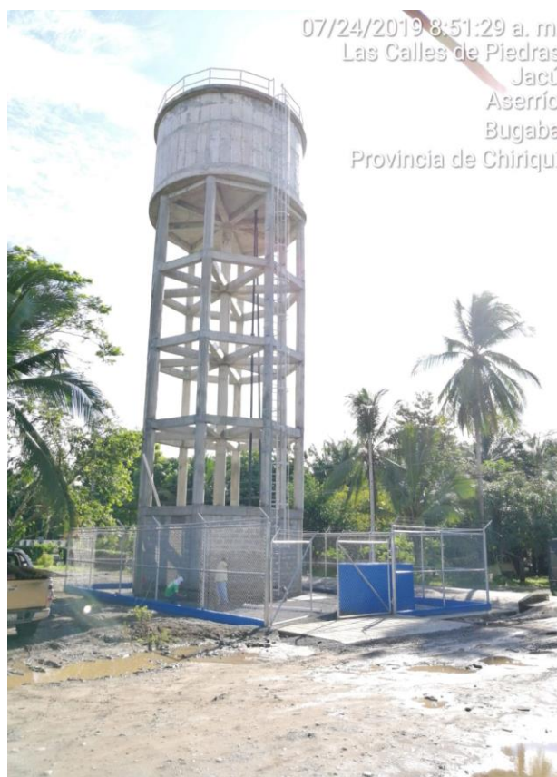
Foto 2: 100% de finalización del Tanque elevado de 35,000 galones, cerca perimetral y pintura con el logo del IDAAN..
