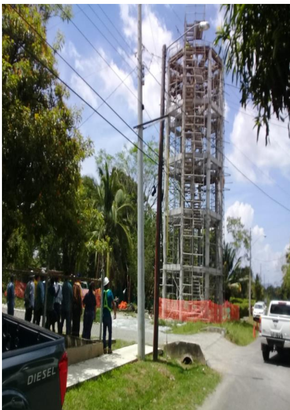
Foto 2: 100% de finalización del Tanque elevado de 35,000 galones, cerca perimetral y pintura con el logo del IDAAN..
