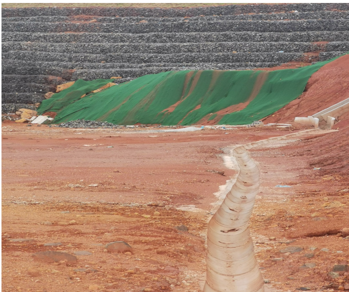
COMPACTACIÓN CUNETAS-CUNETAS – MALLAS Y GAVIONES
