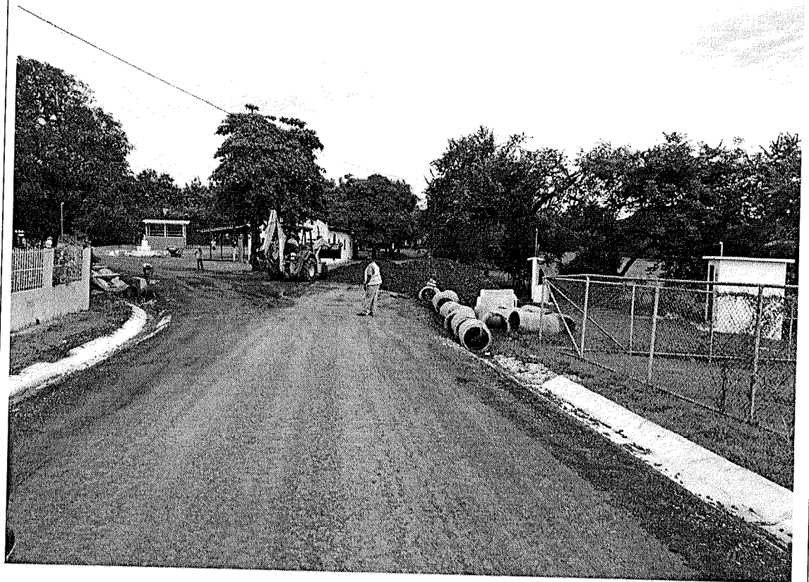
Fig. N° 2 Final del camino Pueblo Nuevo (tramo izquierdo), el cual se une al camino Poblado de las Flores (tramo derecho), se observa construcción d cunetas y trabajos de excavación para colocación de tubería transversal para garantizar el buen flujo del agua y así evitar afectaciones sobre las viviendas cercanas.
