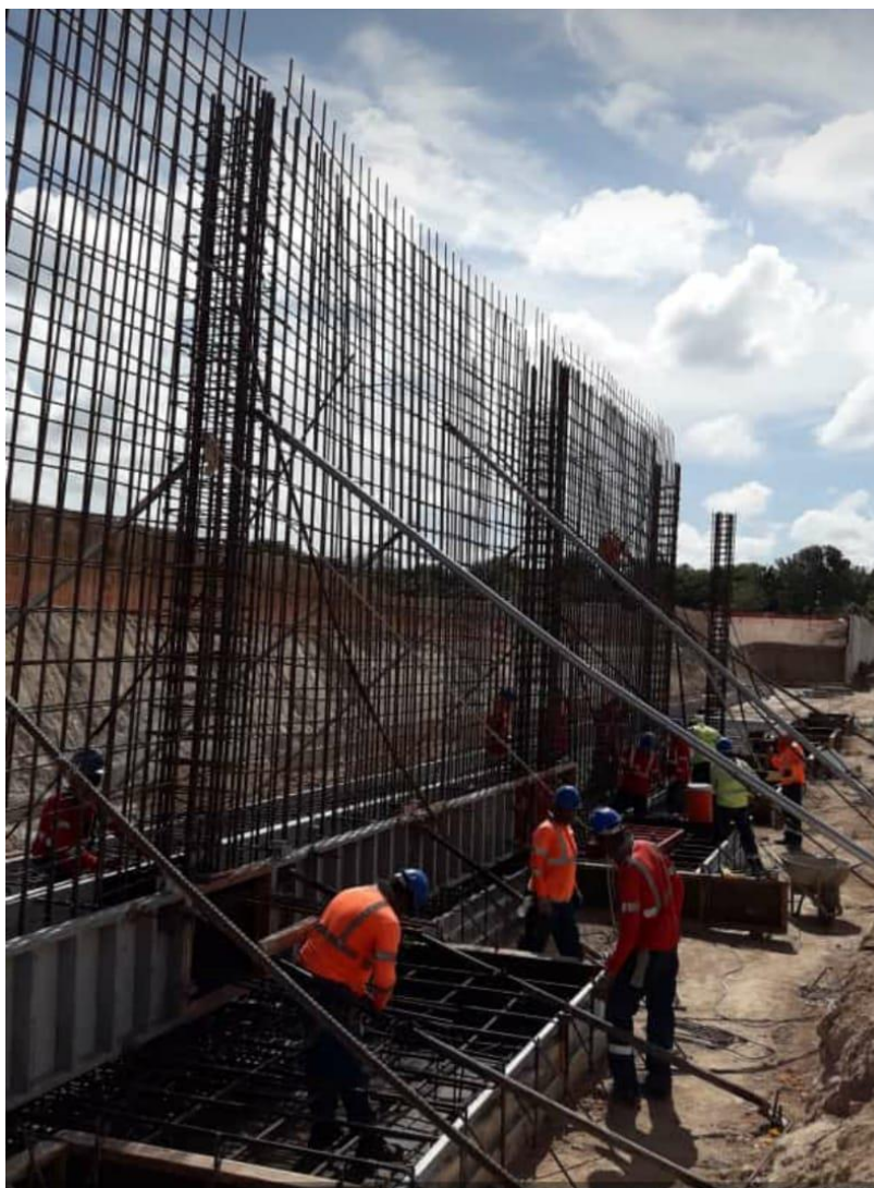
Foto No. A1- 6. Personal preparando áreas para el vaciado de concreto.
