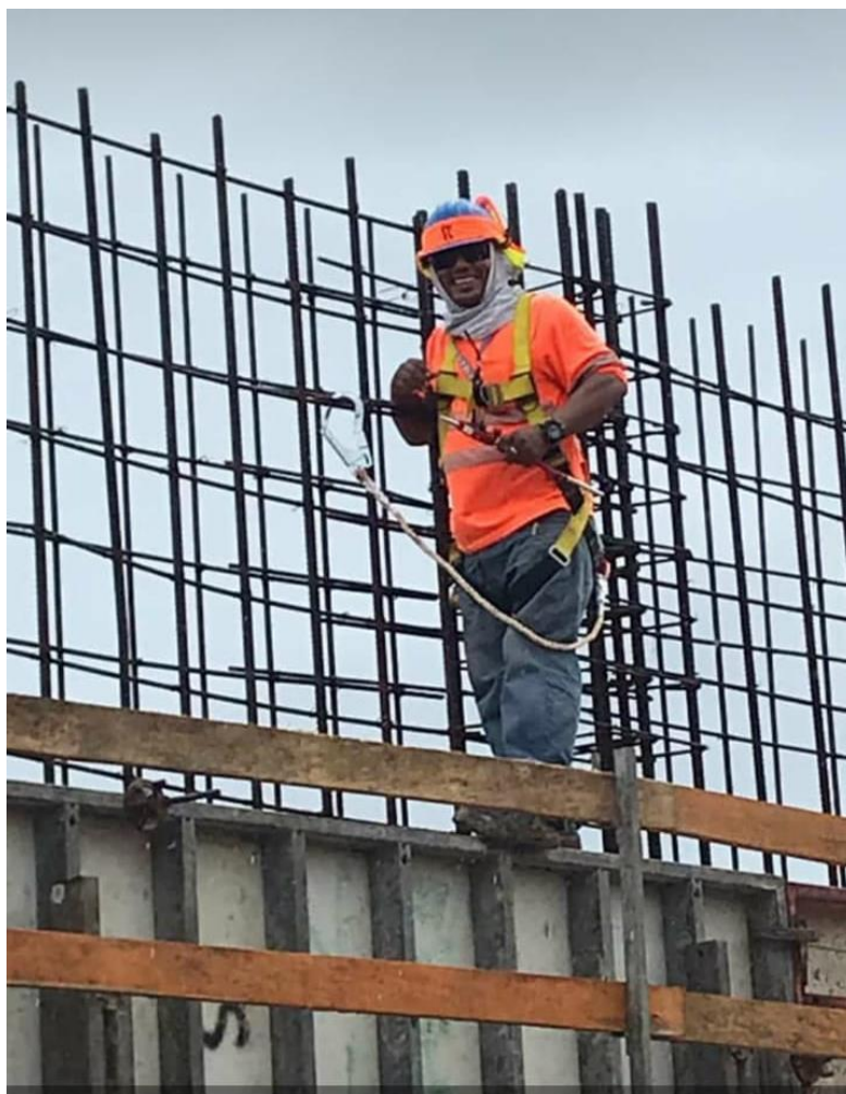
Foto No. A1-8. Personal en proceso de adecuarse para trabajos en altura, uso de la línea de vida.
