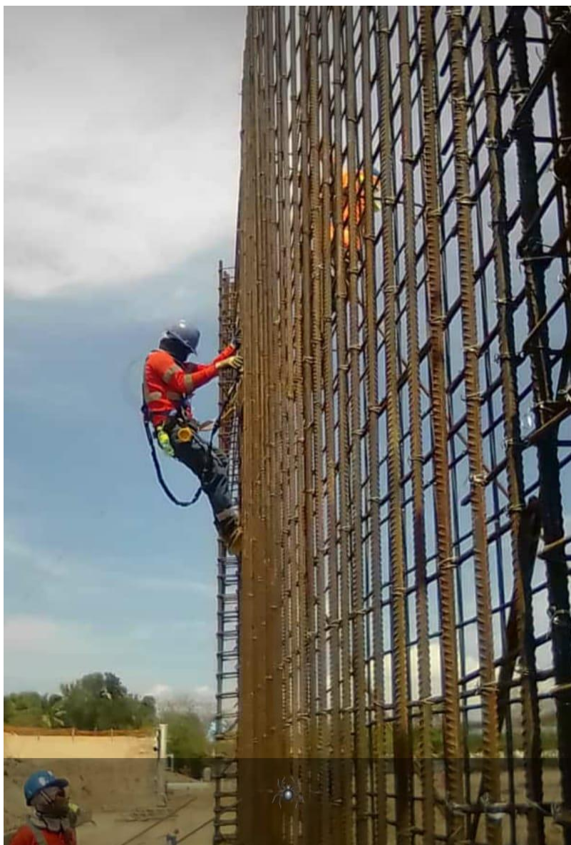
Foto No. A1-4. Personal en uso de la línea de vida.
