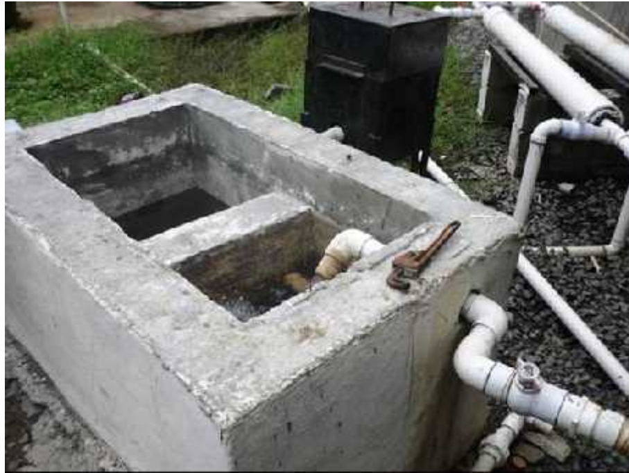
Tanque donde las aguas del proyecto son dispuestas en el sistema de Tratamiento de aguas residuales de POTSA.
