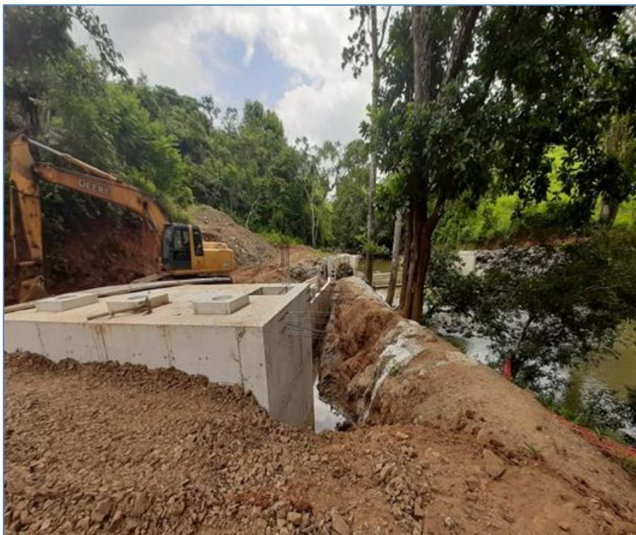
No fue necesario transportar material de excavación durante la colocación de tuberías. El sobrante de tierra de la excavación para colocación de tuberías se integra a la zanja excavada, retornando una superficie estable al sitio intervenido.
