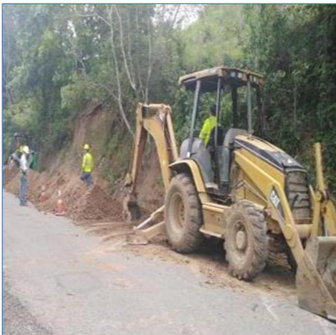
El sobrante de tierra de la excavación para colocación de tuberías se integra a la zanja excavada, retornando una superficie estable al sitio intervenido. Se han reparado las servidumbres intervenidas.
