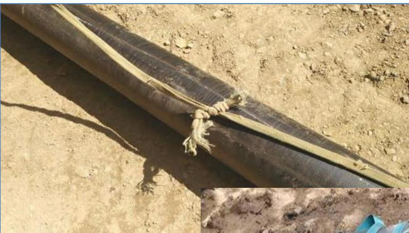
Remplazo de faja para manipulación de tuberías de aducción
