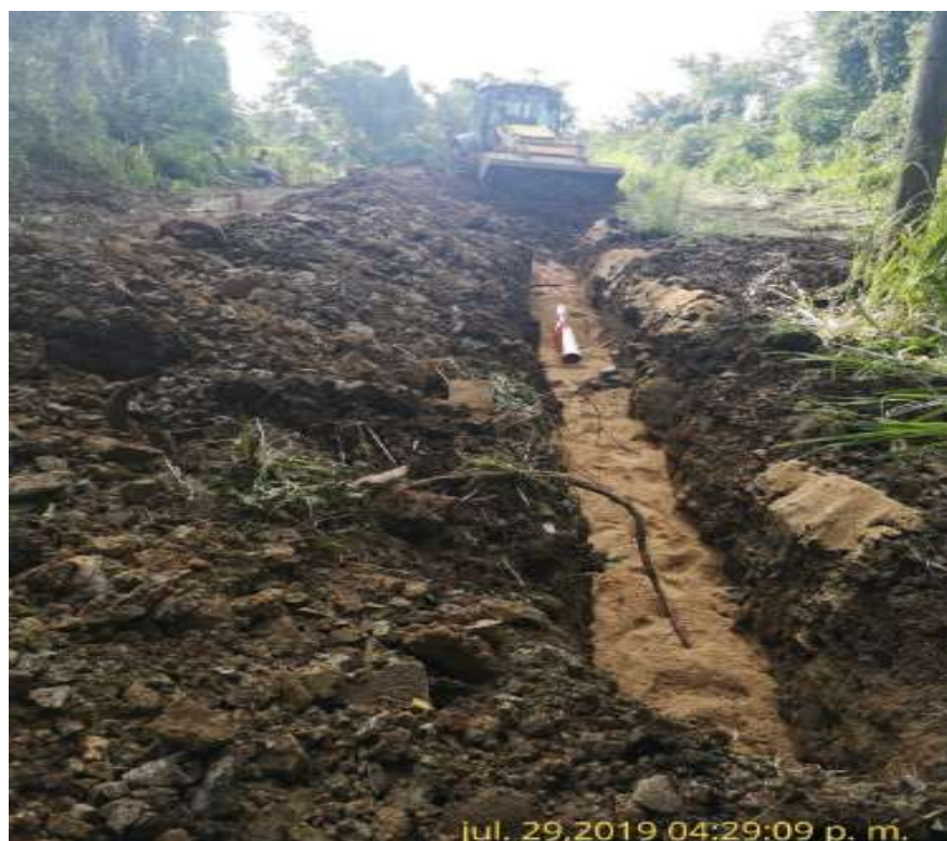
Figura #36. Línea potable
