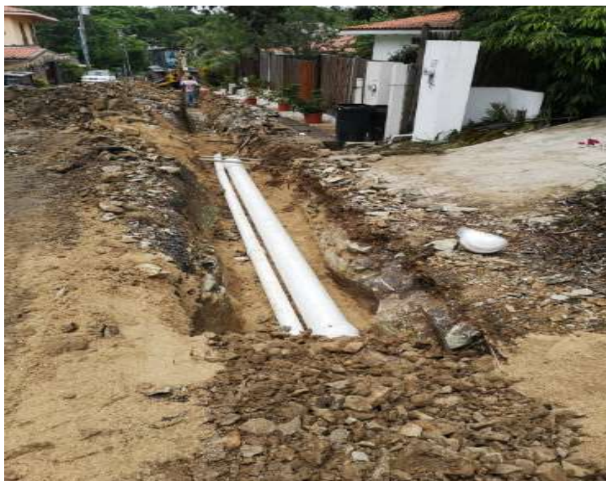
Foto #35. Línea de impulsión y conducción
