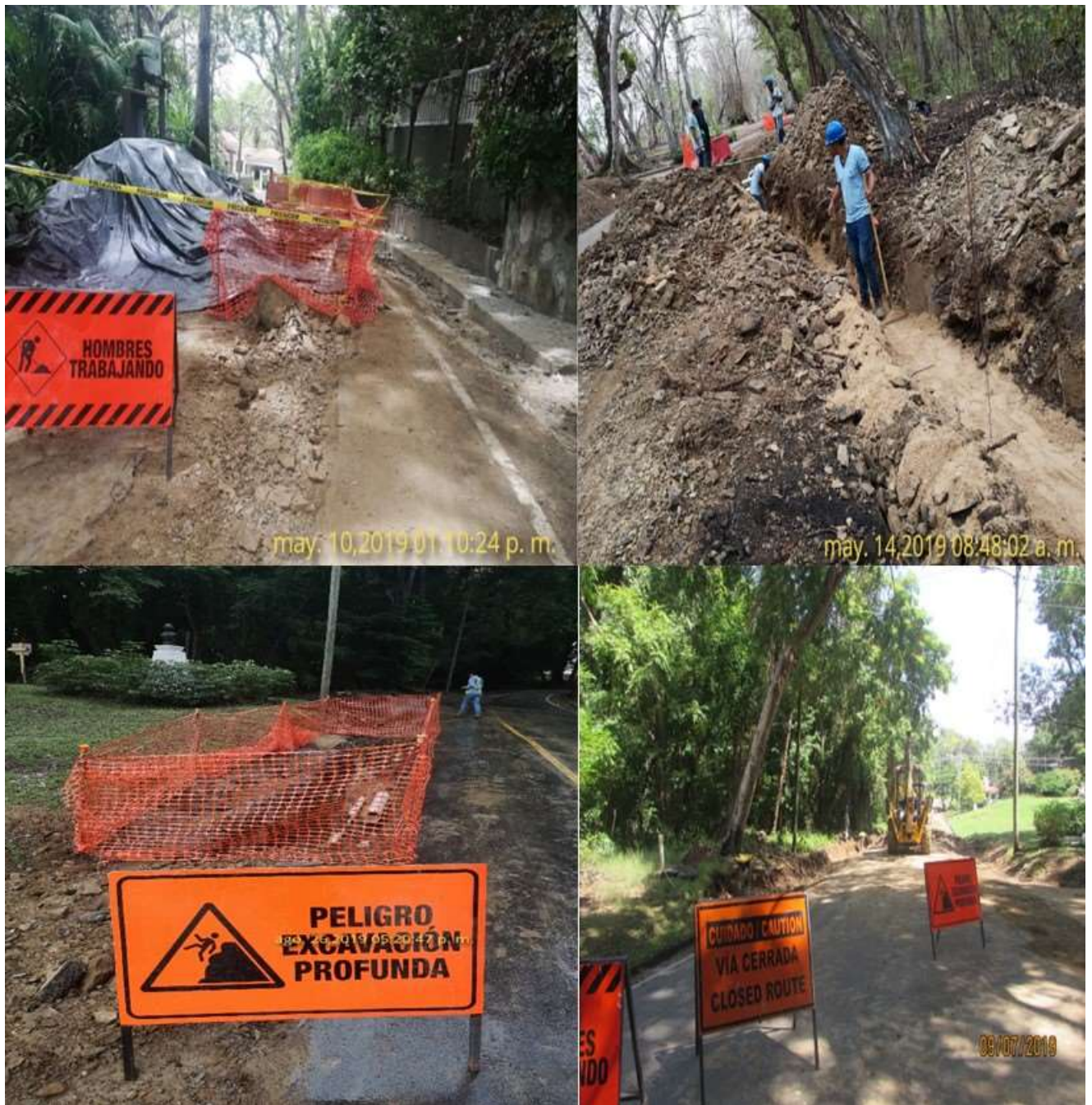
Figura # 8 Se cuenta con señalizaciones para Limitar el acceso de trabajadores y vehículos sólo a las áreas de construcción. (foto mayo 2019)
