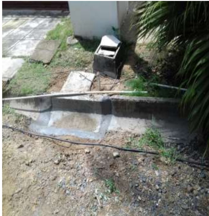
Foto # 13. Colocación de cunetas como obras complementarias de drenaje en los caminos de acceso que han sido alterados por la construcción
