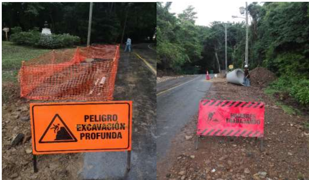
Foto # 27. Material de excavación acumulado y área debidamente señalizada y con letreros de advertencia.
