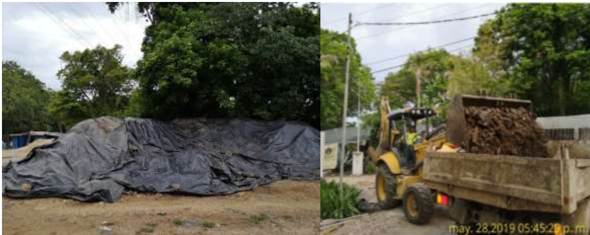
Foto # 4. El material sobrante de las excavaciones, se depositará en lugares previamente aprobados por la inspección, se cubren con lonas plásticas y se reutilizará en otros sitios previamente inspeccionados.
