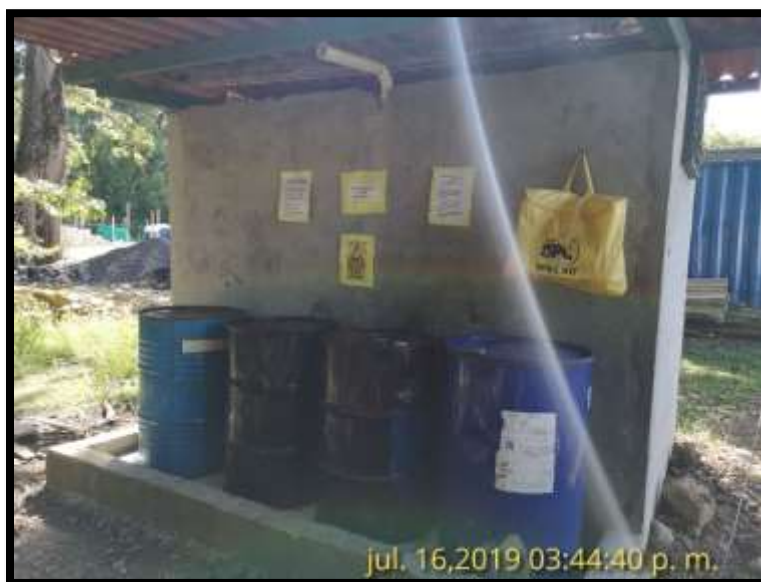
Foto #19. Área de almacenamiento de combustible, con su kit de derrame accesible, área techada y noria de contención.
