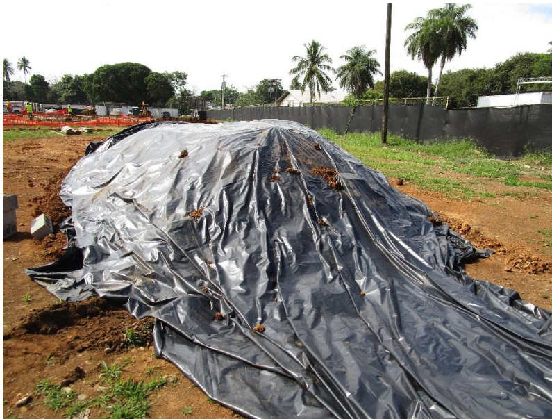
Obsérvese la colocación de lona plástica como medida de control de erosión.
