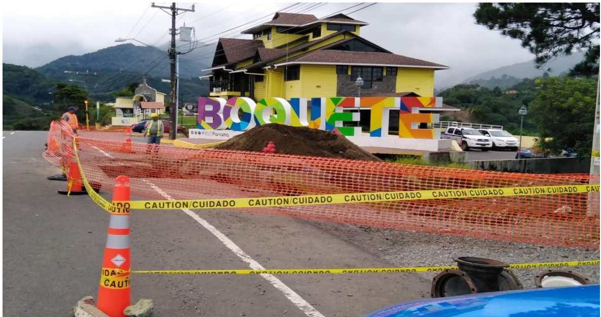
Fotografía 3. Uso de dispositivos para control de transito vehicular
