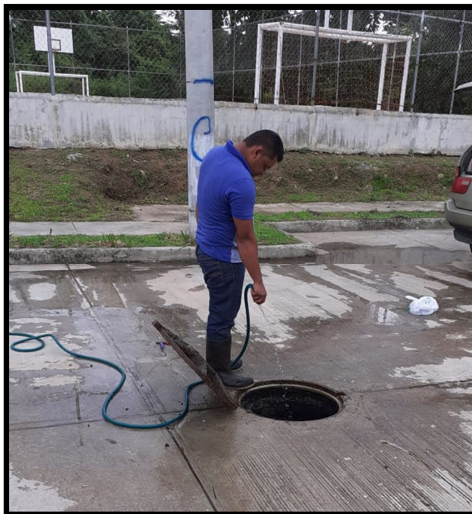
Foto N°2 y Foto N°3. Limpieza de drenajes pluviales.
