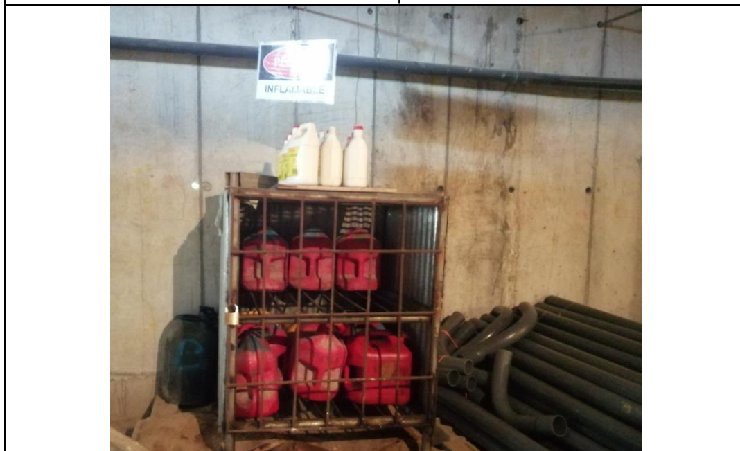
Fotografía No. 7: Lugar de almacenamiento de combustible con su noria de contención.
