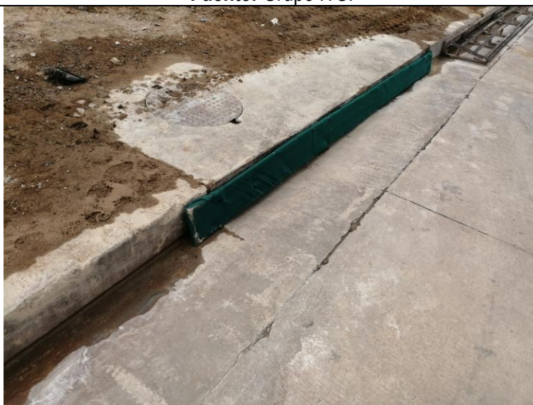
Fotografía No. 11: Se observa alcantarillado con grava y malla para atrapar los sedimentos. Fuente: Grupo ITS.
