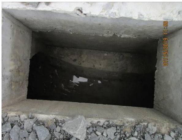
Imágenes 16 y 17. Vista de los tragantes pluviales construidos durante este periodo
