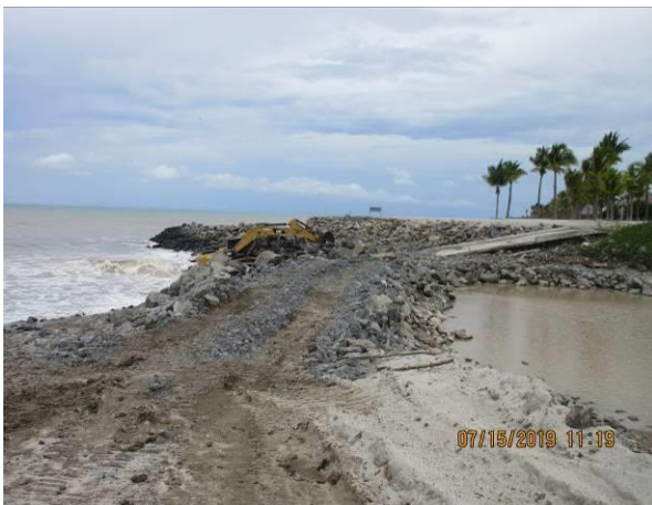
Imágenes 20 y 21. Vado temporal construido en la desembocadura del Río Hato
