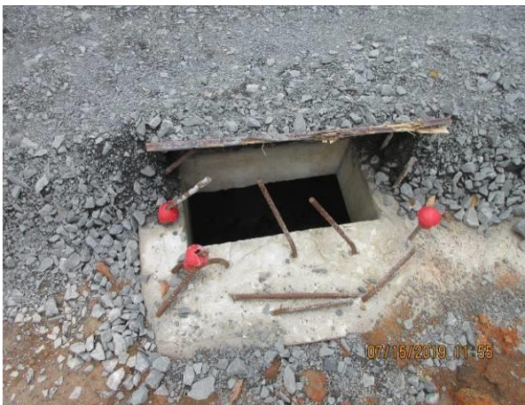
Imágenes 16 y 17. Vista de los tragantes pluviales construidos durante este periodo
