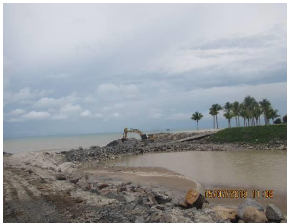
Imágenes 20 y 21. Vado temporal construido en la desembocadura del Río Hato
