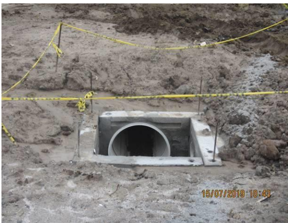
Imágenes 18 y 19. Vista de las tuberías y cabezales de descarga pluvial
