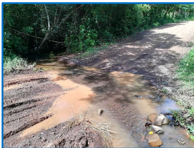
Figura N° 20. Quebrada El Papayo
