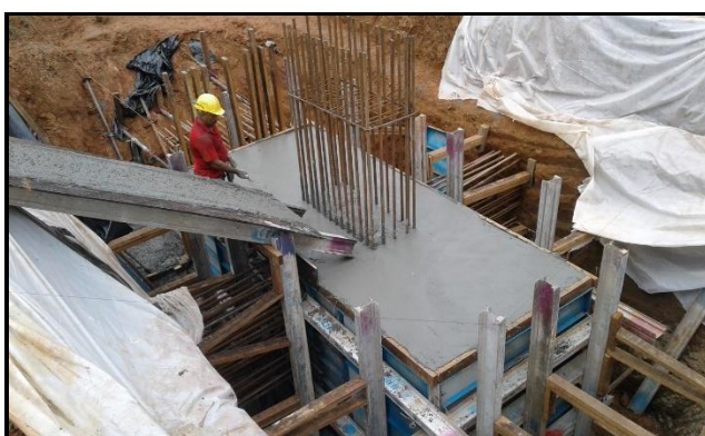
Fotografías N° 2-7 y 2-8: Vaciado
