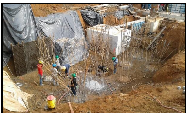
Fotografías N° 2-9 y 2-10: Construcción de cabezales
