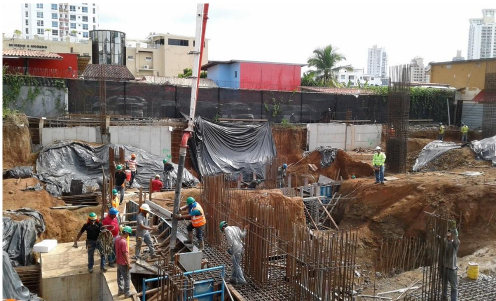
Los apilamientos de material y suelos descubiertos eran cubiertos con lonas plásticas.
