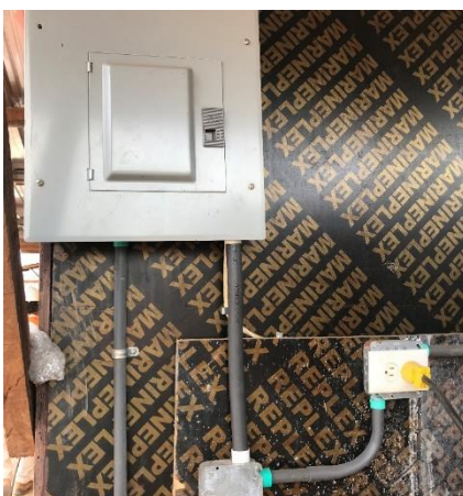
Fotografía 5-1: Paneles eléctricos sin señalización
