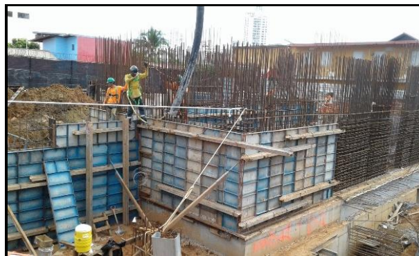
Fotografías N° 2-9 y 2-10: Construcción de cabezales
