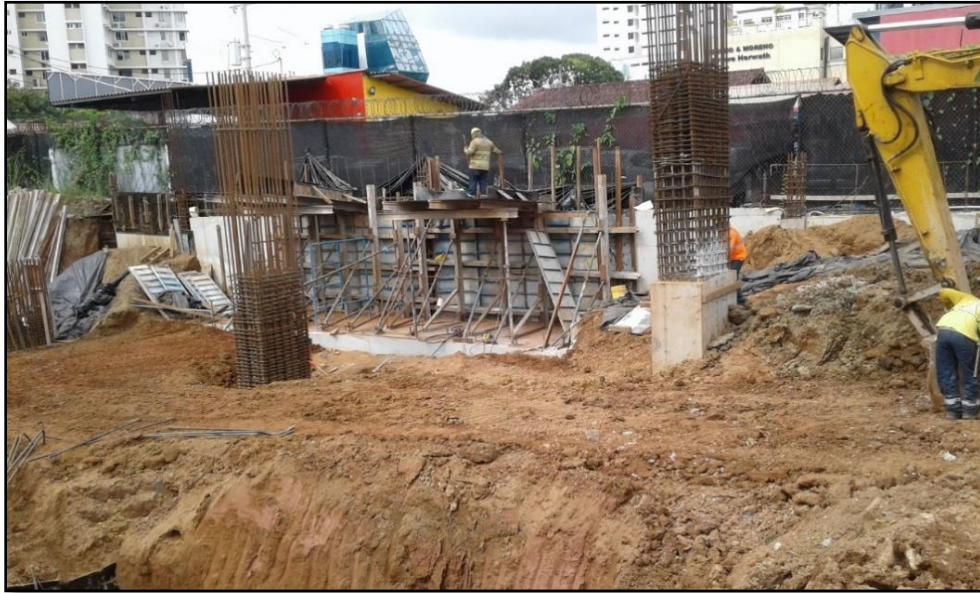
Fotografía N° 2-11: Construcción de columnas
