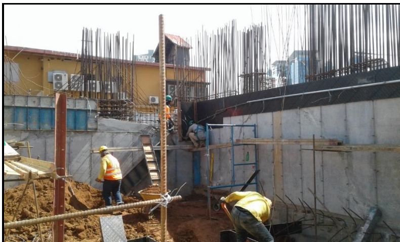
Fotografía N° 2-13: Construcción de muro de contención
