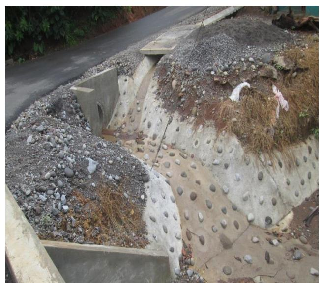
Se evidencia la construcción de cunetas y zampeados; como medidas permanentes de control de erosión.
