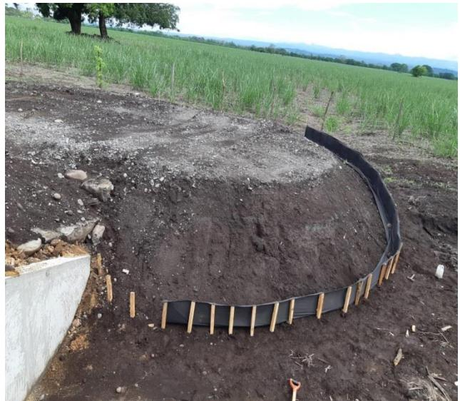
Controles Ambientales establecidos en cajón pluvial ubicado en las estación 1+050 y 4+850 correspondiente a calle San Pablo Nuevo. Se colocan mallas geotextil y disipadores de energía.
