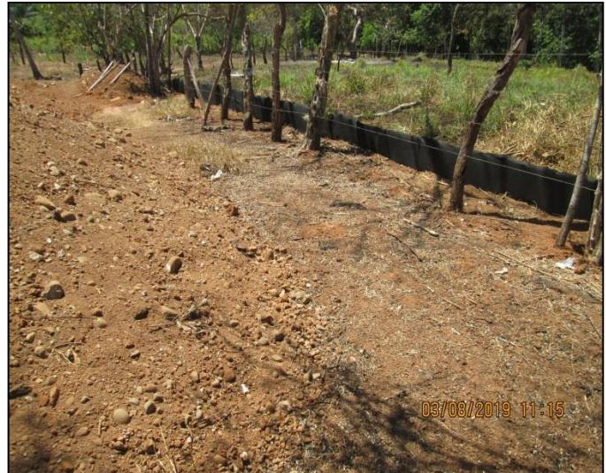
Controles de erosión establecidos en áreas de botaderos; se colocan mallas con geotextil y se procede a la conformación de los mismos.
