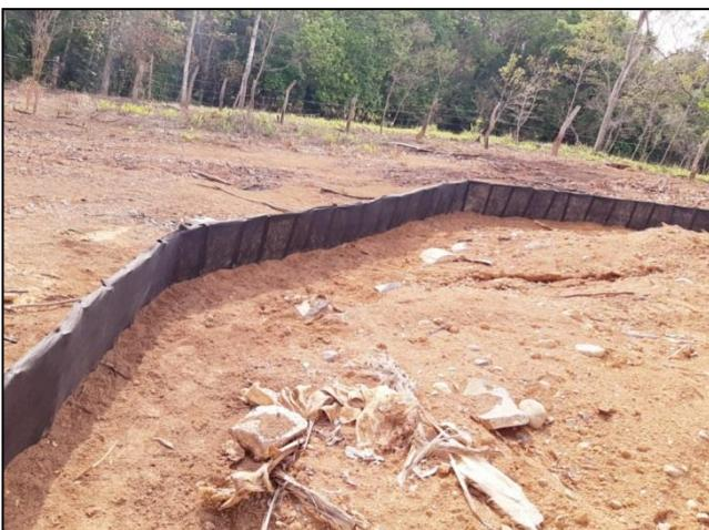
Control de erosión en áreas de rellenos; se colocan mallas de geotextil y se reutiliza material vegetal.
