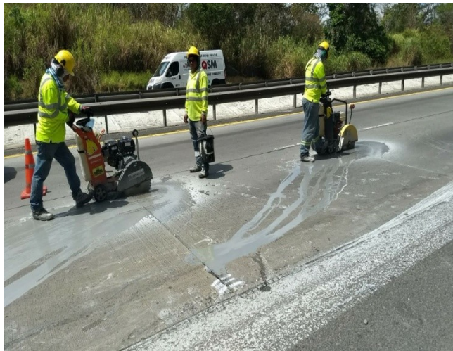
Ilustración 5-11 Corte de lozas, se utilizan las maquinas de corte con agua y carro tanque en proyecto, para el control de polvo
