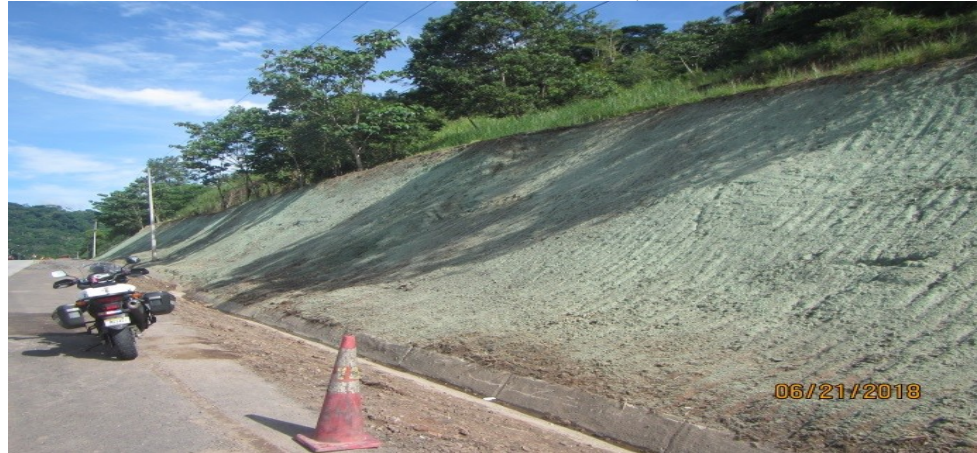
Ilustración 5-10. Control de erosión de los suelos, Hidrosiembra en talud
