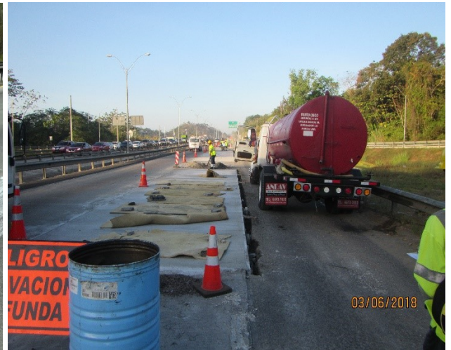
Ilustración 5-11 Corte de lozas, se utilizan las maquinas de corte con agua y carro tanque en proyecto, para el control de polvo
