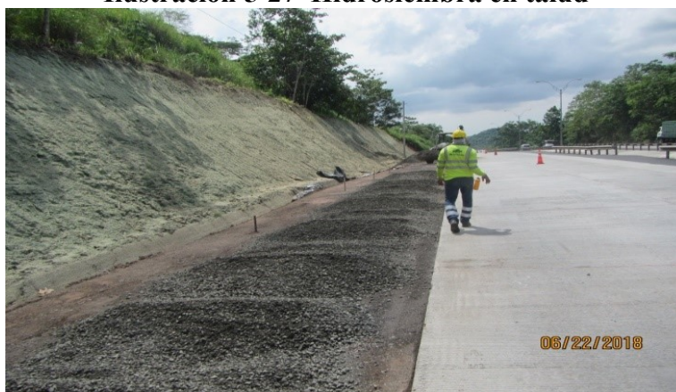
Ilustración 5-27 Hidrosiembra en talud
