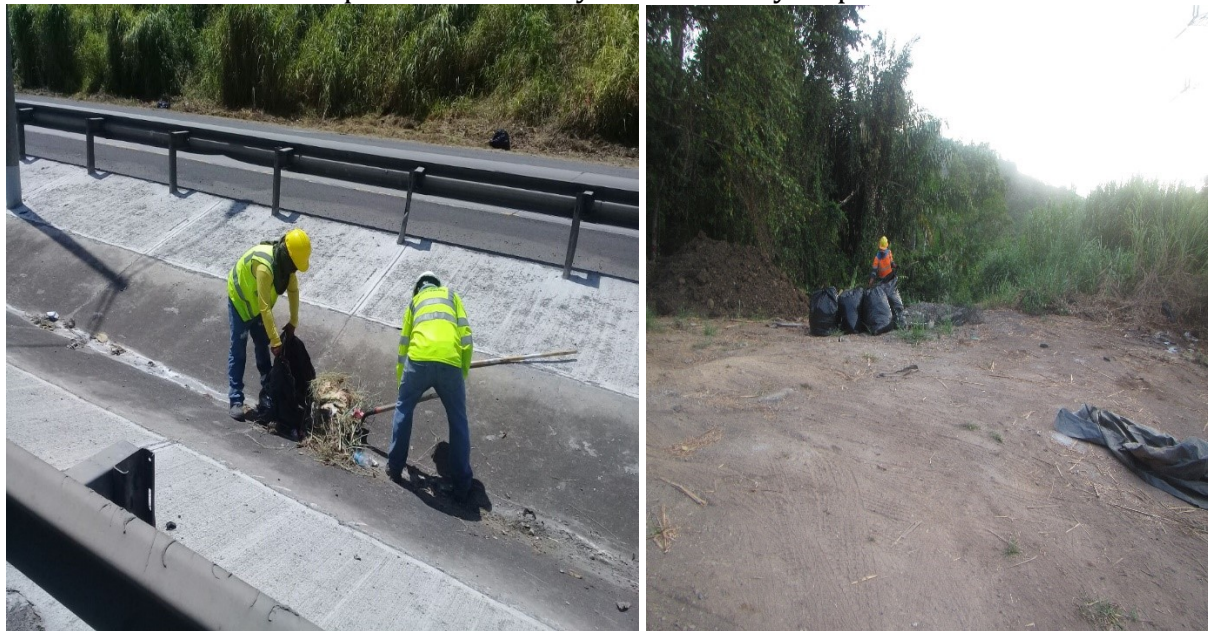
Ilustración 5-6. Limpieza de cunetas y alcantarillas y disposicion de la basura
