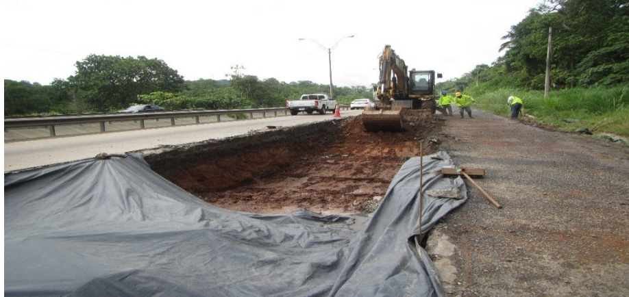
Ilustración 5-14 Protección con polietileno contra el arrastre de las lluvias de los materiales y suelos
