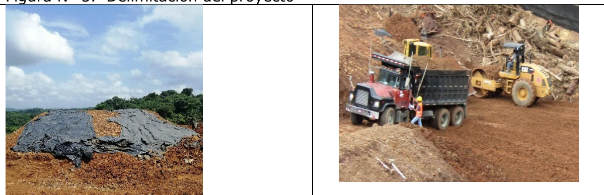
Figura Nº 6. Material excedente de excavaciones cubierto con lona plástica
