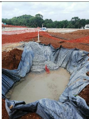
Foto N° 16. Tinas de lavado de concreteras.
