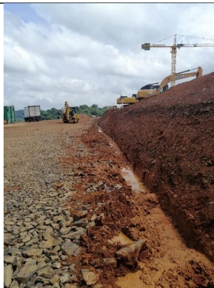
Foto N° 8. Drenajes y sistemas de contención de material
