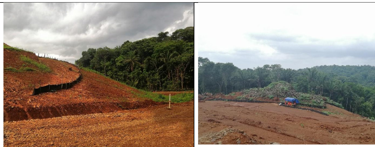
Foto nº 4. Barreas existentes para evitar arrastre de sedimentos
