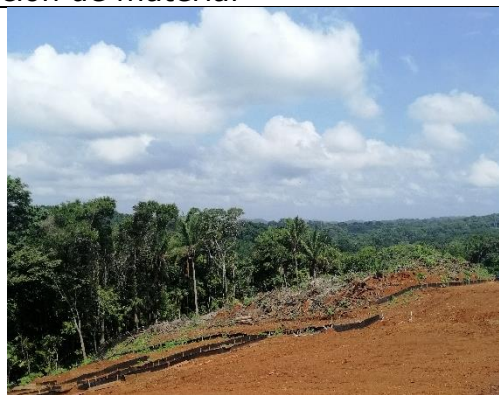
Foto N° 8. Drenajes y sistemas de contención de material
