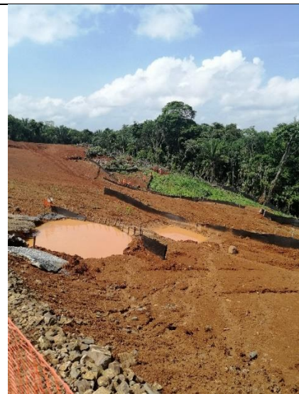
Foto N° 8. Drenajes y sistemas de contención de material
