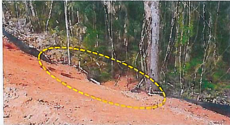
Barrera externa perimetral de geotextil derribada
