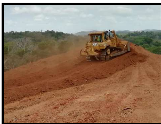
Fotografía 7: Retiro de la primera capa de tierra
