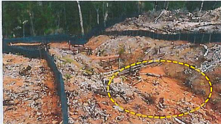
Acumulación excesiva de sedimento
