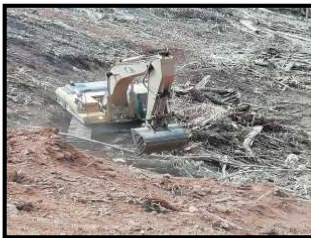
Fotografía 9: Retiro de cubierta vegetal
