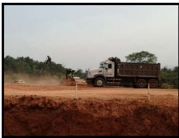
Fotografía 22: Extracción de material no servible (área 14)
