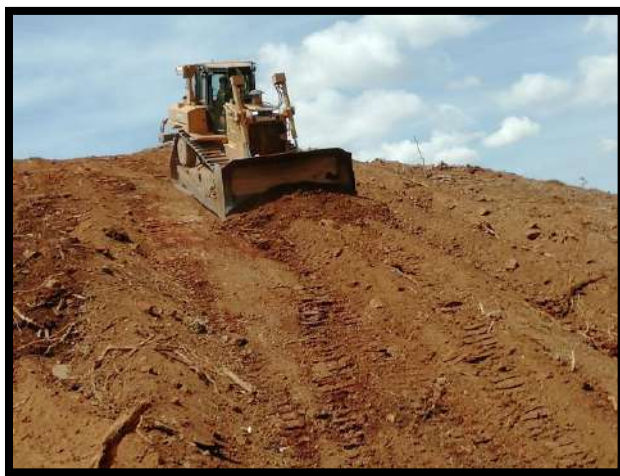
Fotografía19: Nivelación del terreno
