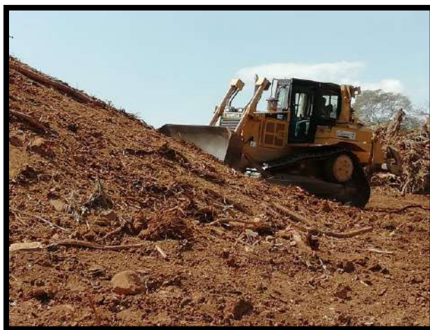
Fotografía 8: Remoción de primera cubierta de tierra
