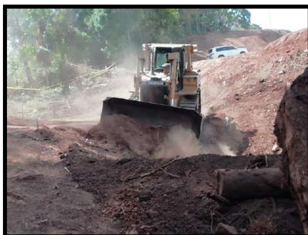
Fotografía18: Nivelación del terreno
