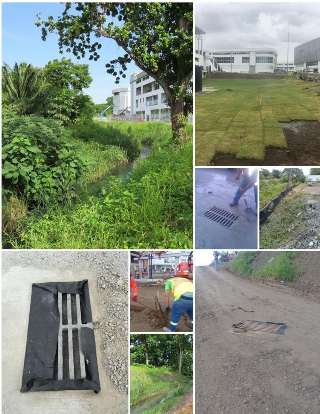
Foto 3: CONTROL DE EROSIÓN Y SEDIMENTOS
